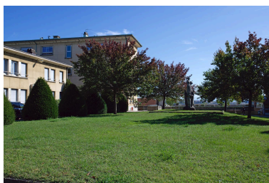
Vue d'ensemble, l'œuvre dans son contexte. Phot. Michel Pérès IVR84_20196900653NUCA
