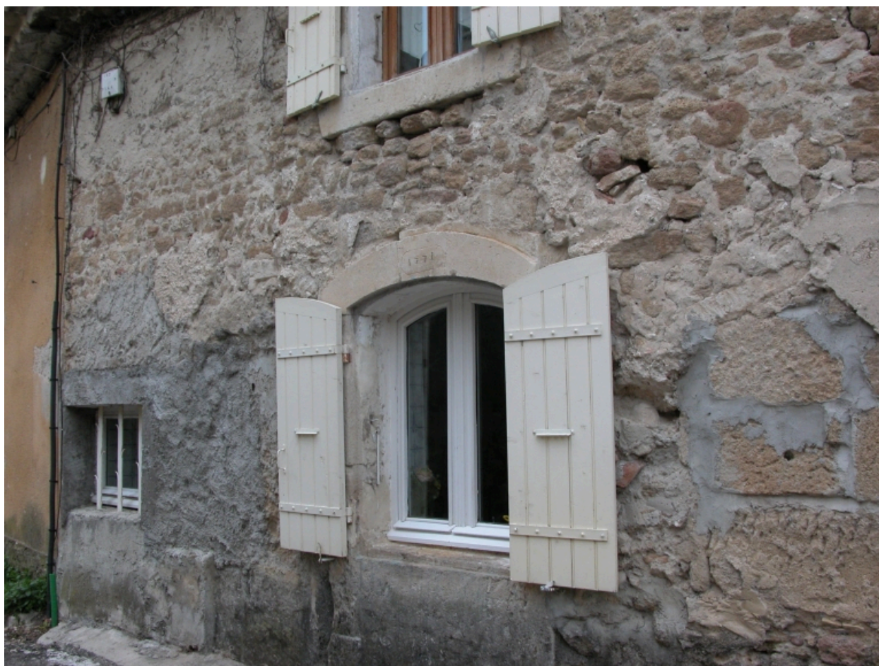
Détail de la façade ouest de la maison.
