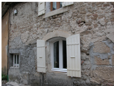
Détail de la façade ouest de la maison. Phot. Geneviève Jourdan IVR82_20092600025NUCA
