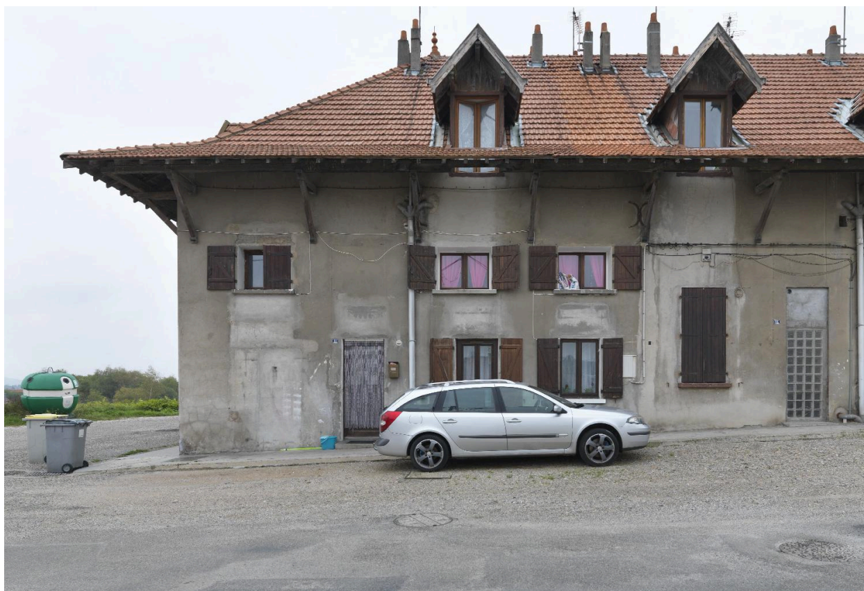
travée Nord du bâtiment du Réveil
