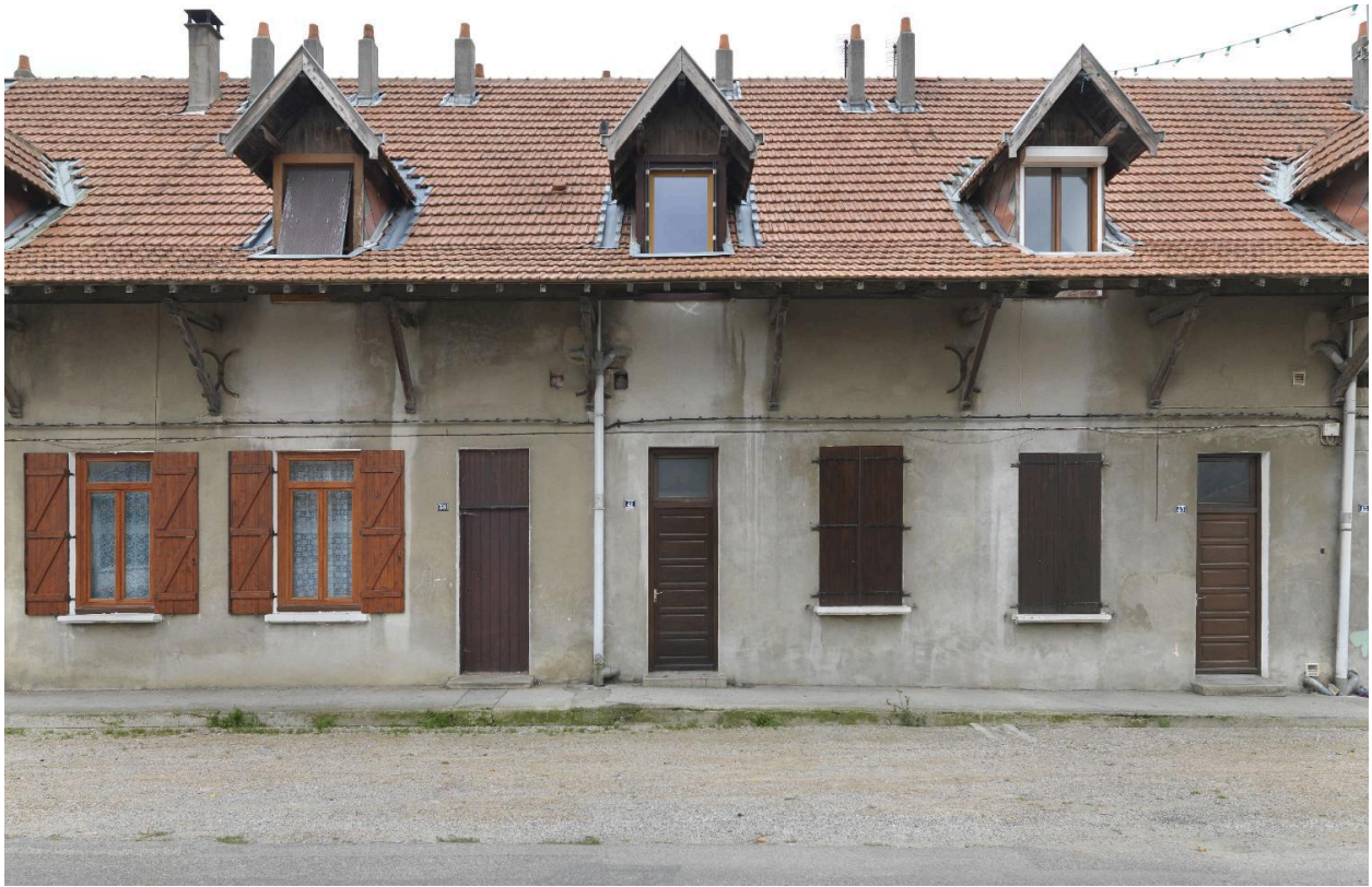
Série de travées centrales de la cité du Réveil
