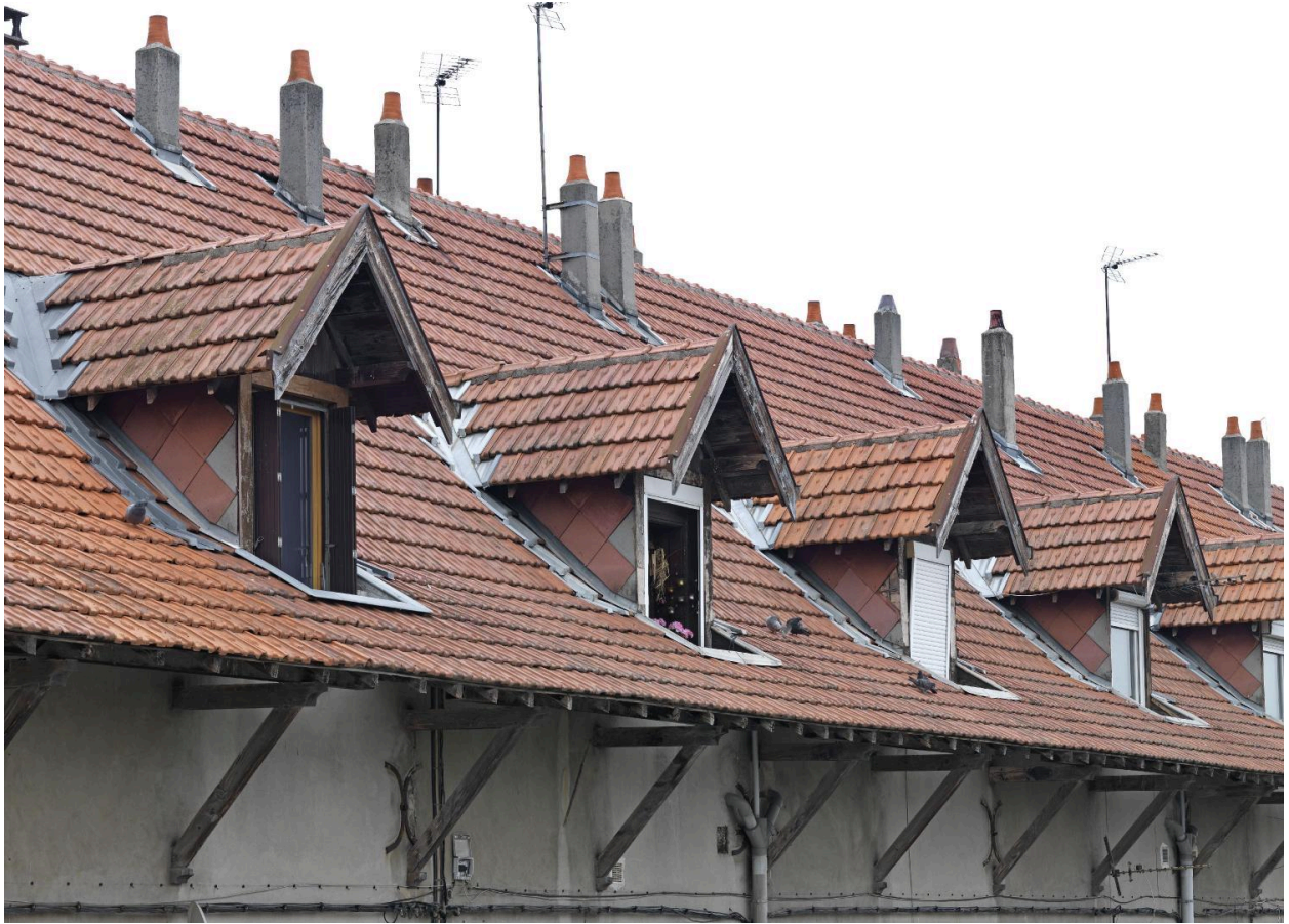
Détail toiture lucarne (chiens assis) du bâtiment du Réveil
