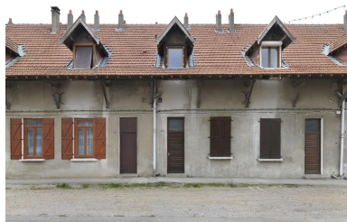
Série de travées centrales de la cité du Réveil Phot. Thierry Leroy IVR82_20133800124NUCAQ
