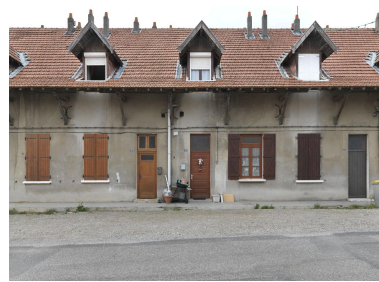
Série de travées centrales du bâtiment du Réveil Phot. Thierry Leroy IVR82_20133800116NUCAQ
