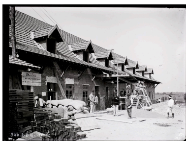
La cité du Réveil en construction 2-8-1916 (Musée de Bourgoin-Jallieu) Phot. Nadine Halitim-Dubois IVR84_20183800345NUC
