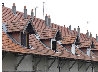
Détail toiture lucarne (chiens assis) du bâtiment du Réveil Phot. Thierry Leroy IVR82_20133800107NUCA
