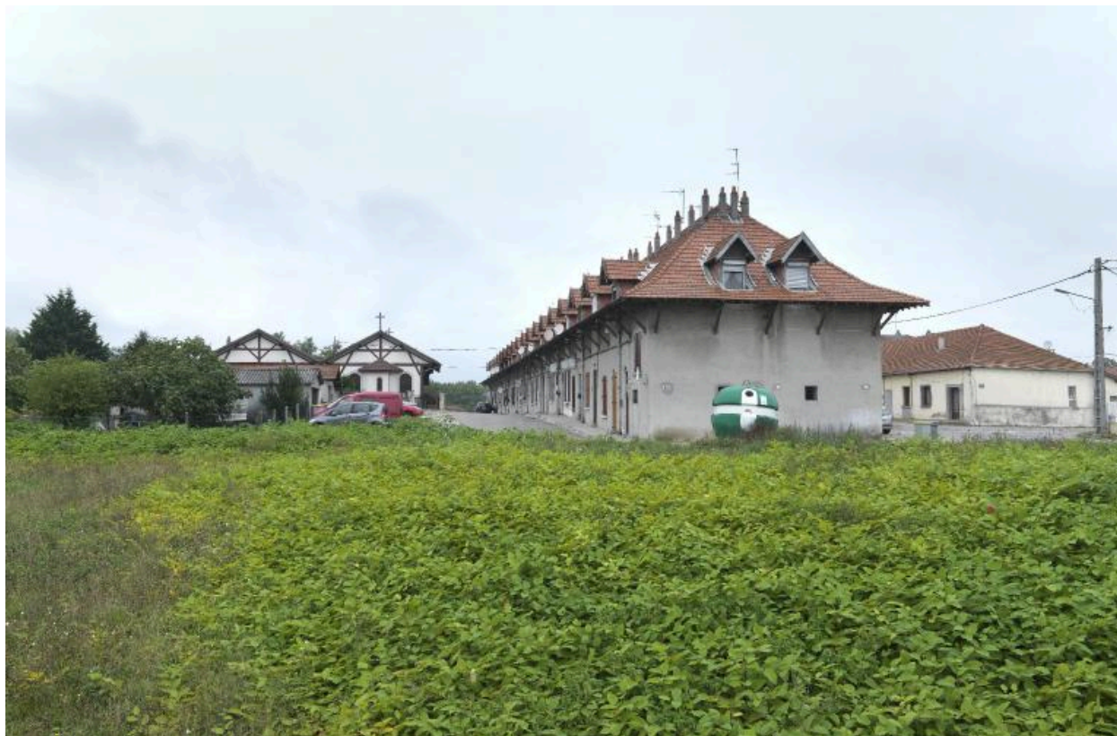
Vue d'ensemble du bâtiment du Réveil avec l'école et l'église
