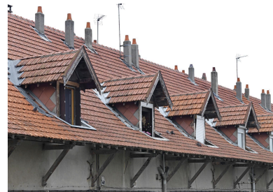
Détail toiture lucarne (chiens assis) du bâtiment du Réveil Phot. Thierry Leroy IVR82_20133800107NUCA
