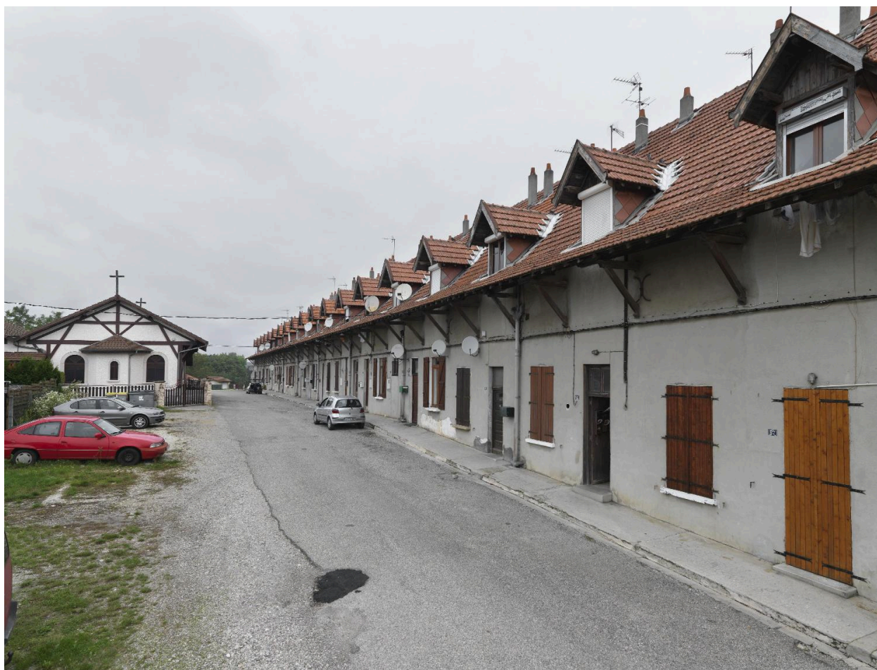
Vue de la rue principale de la cité
