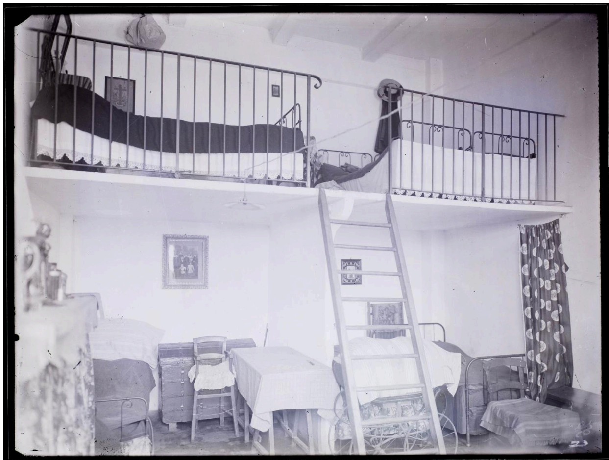
Vue intérieur d'un logement de la cité du Réveil (arch Musée de Bourgoin-Jallieu)
