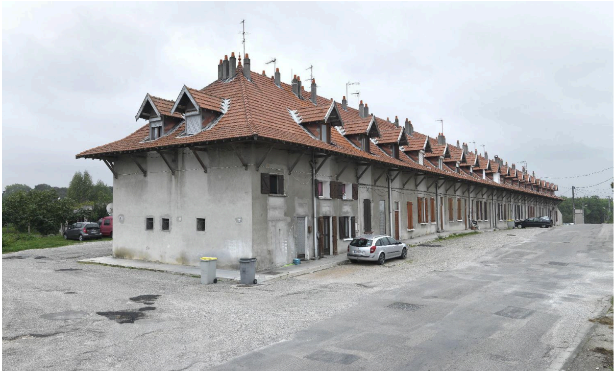
Vue d'ensemble Nord du bâtiment du Réveil
