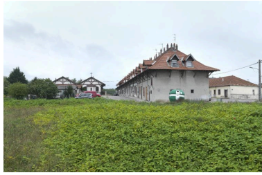
Vue d'ensemble du bâtiment du Réveil avec l'école et l'église Phot. Thierry Leroy IVR82_20133800102NUCAQ
