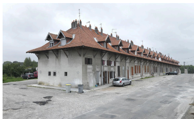
Vue d'ensemble Nord du bâtiment du Réveil Phot. Thierry Leroy IVR82_20133800108NUCA
