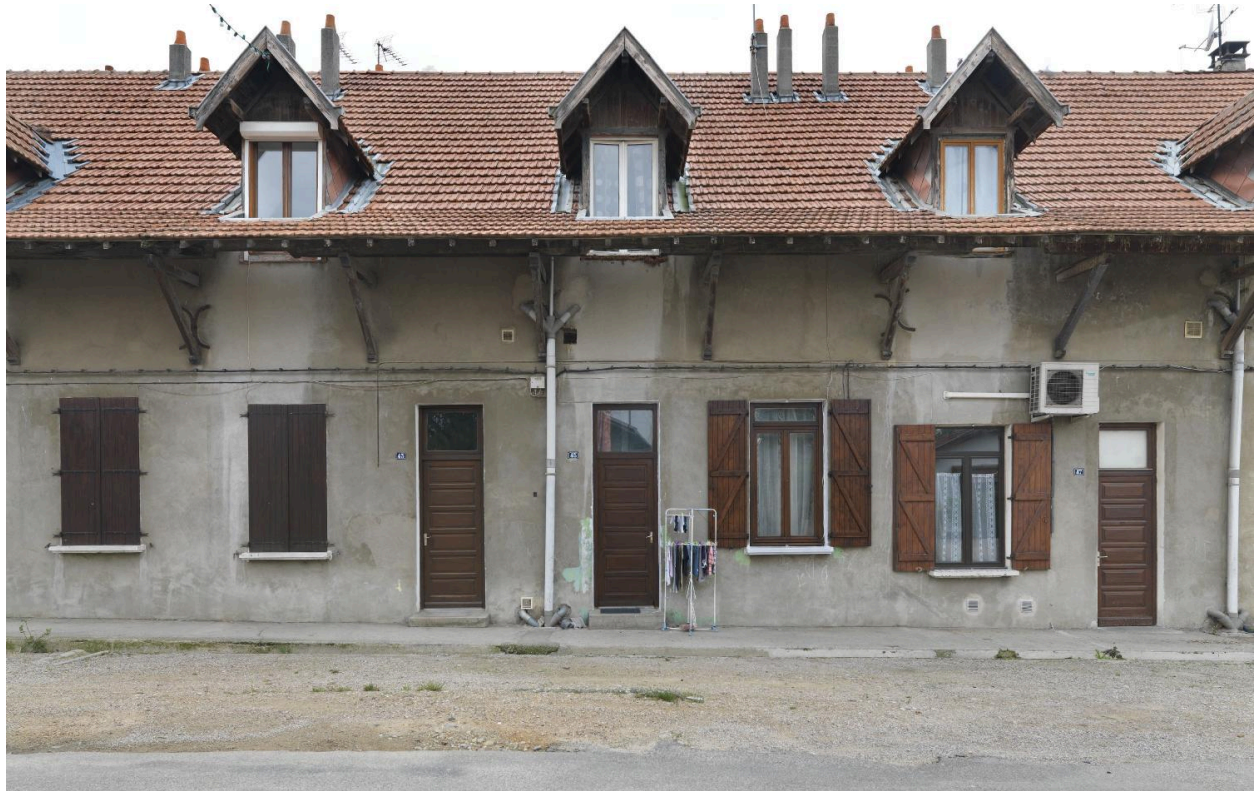
Série de travées centrales du bâtiment de la cité du Réveil
