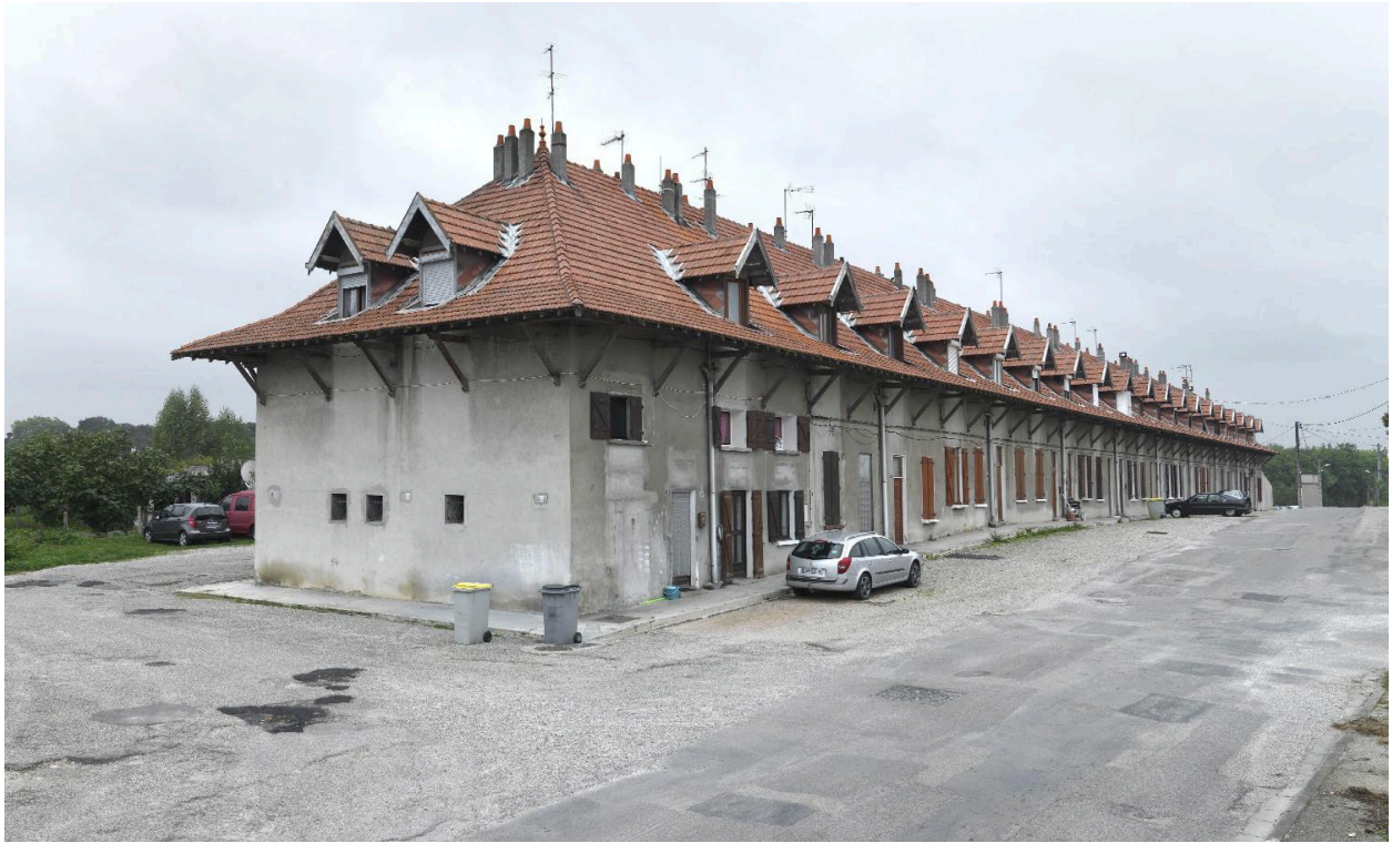
Vue d'ensemble Nord du bâtiment du Réveil
