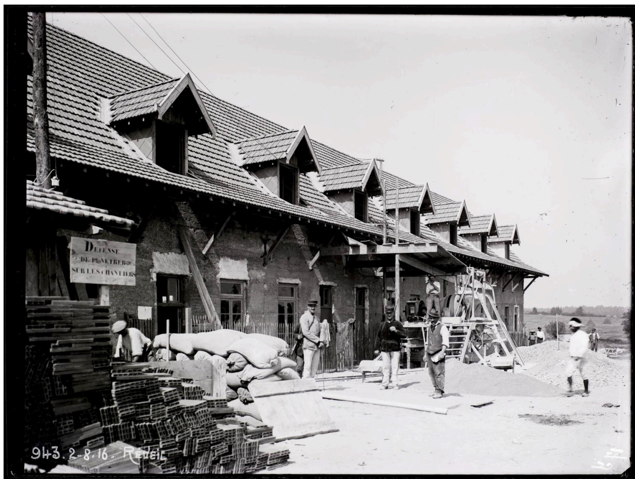
La cité du Réveil en construction 2-8-1916 (Musée de Bourgoin-Jallieu)
