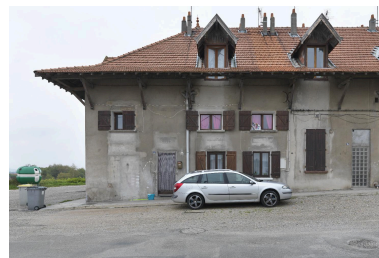
travée Nord du bâtiment du Réveil Phot. Thierry Leroy IVR82_20133800109NUCAQ
