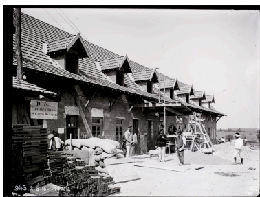
La cité du Réveil en construction 2-8-1916 (Musée de Bourgoin-Jallieu) Phot. Nadine Halitim-Dubois IVR84_20183800345NUC
