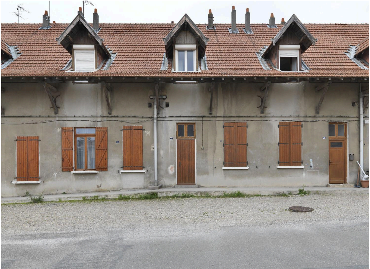
Série de travées centrales du bâtiment du Réveil
