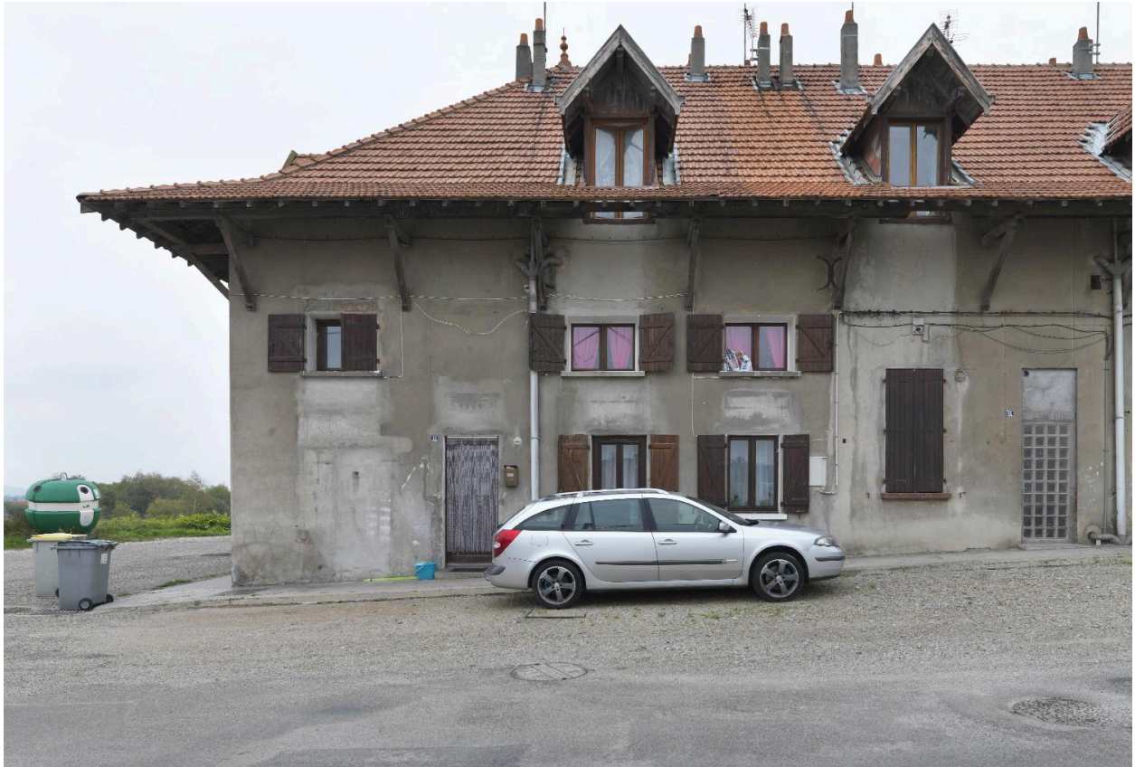
travée Nord du bâtiment du Réveil
