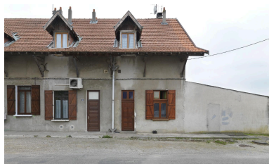
Travée sud du bâtiment du Réveil Phot. Thierry Leroy IVR82_20133800127NUCAQ
