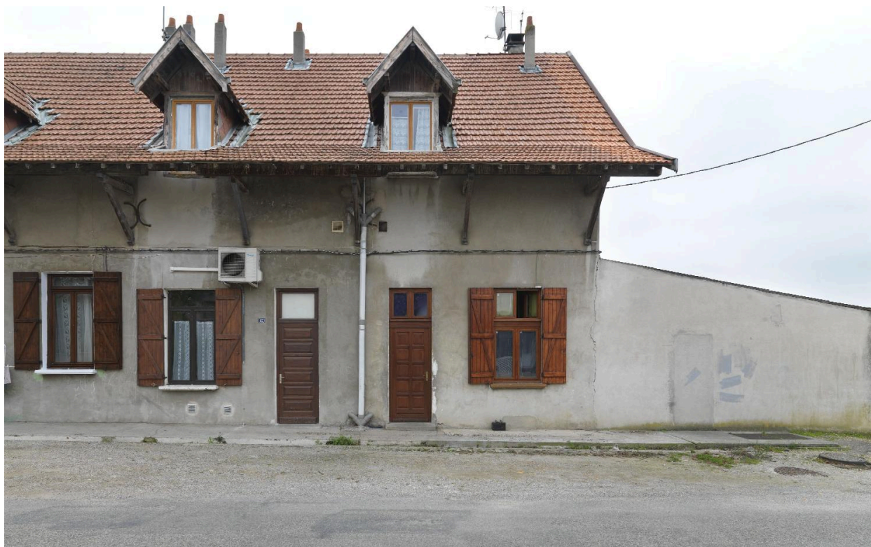
Travée sud du bâtiment du Réveil
