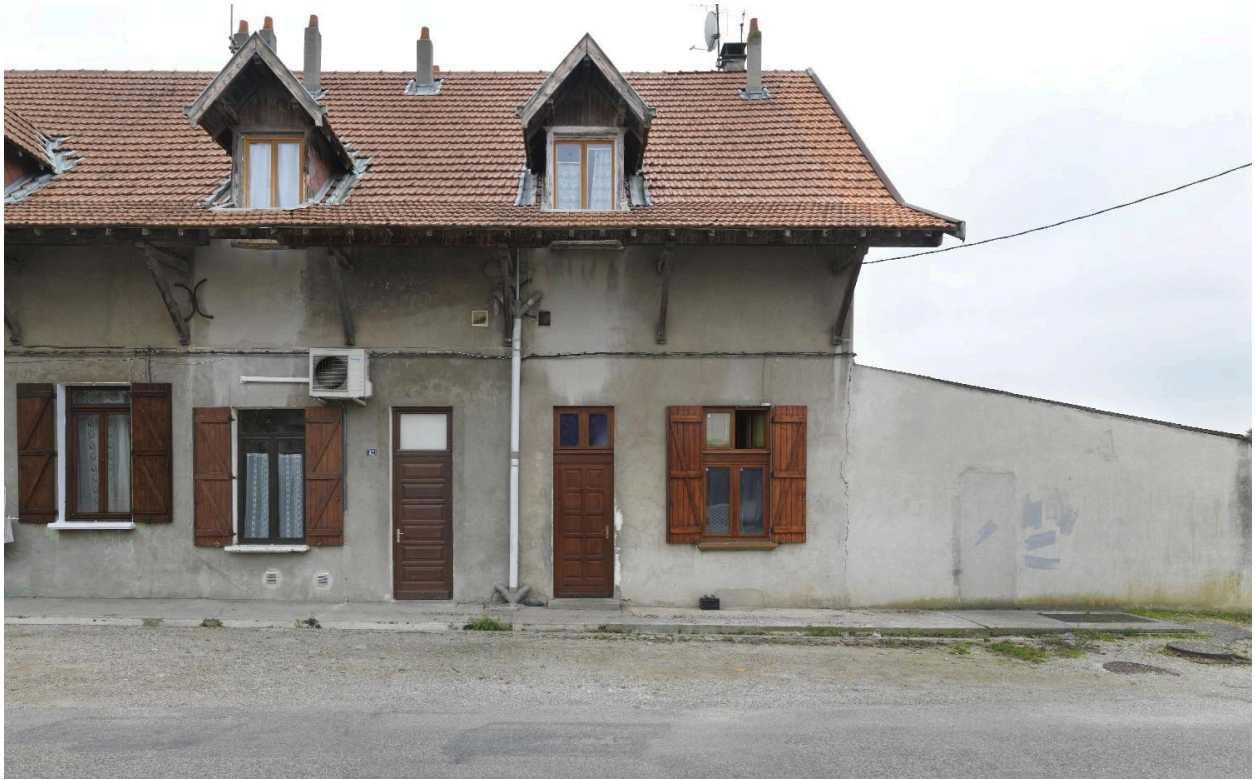
Travée sud du bâtiment du Réveil
