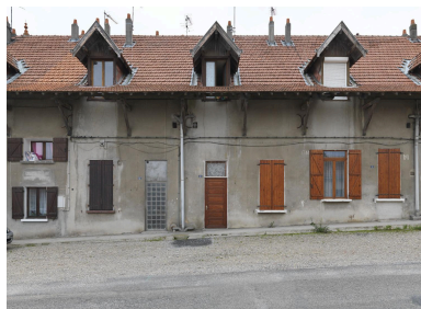
Série de travées du bâtiment du Réveil Phot. Thierry Leroy IVR82_20133800112NUCAQ
