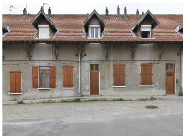
Série de travées centrales du bâtiment du Réveil Phot. Thierry Leroy IVR82_20133800113NUCAQ
