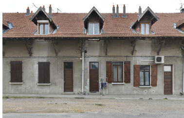
Série de travées centrales du bâtiment de la cité du Réveil Phot. Thierry Leroy IVR82_20133800125NUCAQ
