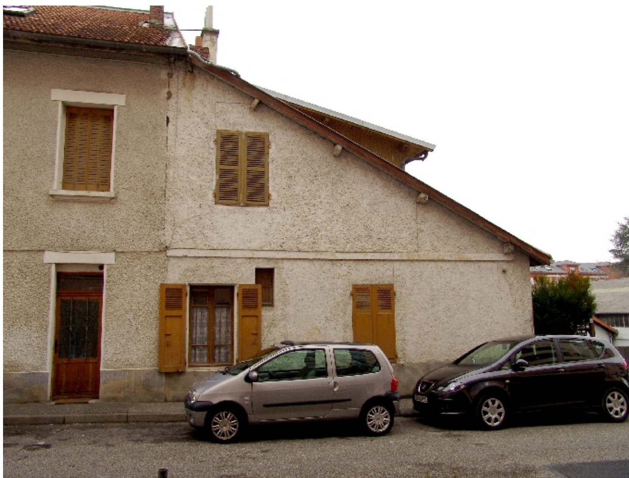
Façade de la partie droite
