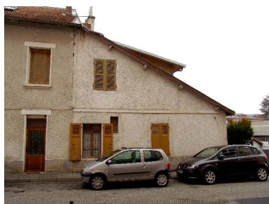
Façade de la partie droite Phot. François Fouger IVR82_20097300164NUCA
