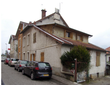
Vue d'ensemble depuis le nord Phot. François Fouger IVR82_20097300165NUCA
