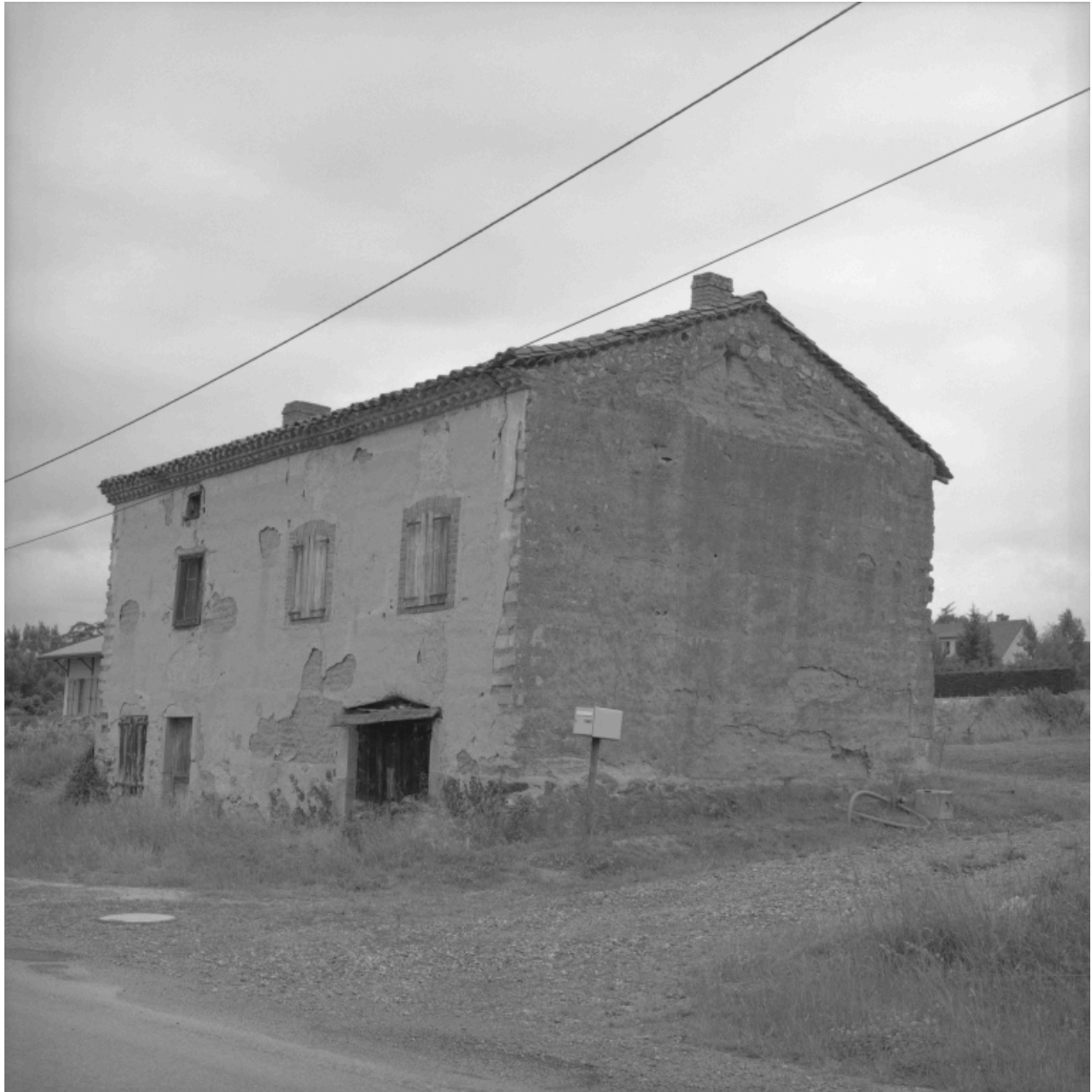
Pralong, le Pont, parcelle 1988 A1 164. Vue d'ensemble, de trois-quarts droit.
