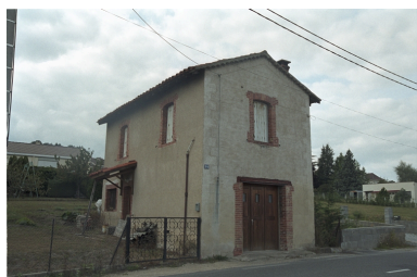
Boën, l'Annet, parcelle 1986 AC 310. Vue d'ensemble de trois quarts gauche. Phot. Caroline Guibaud IVR82_20034200824ZE
