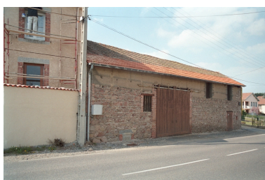
Boën, la Planète-Ouest, parcelle 1986 AI 137. Vue d'ensemble de face. Phot. Thierry Monnet IVR82_20054200161ZE
