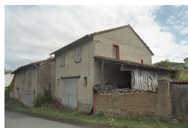
Leigneux, le Bourg, parcelle 1987 AI 818. Vue d'ensemble de trois quarts droit. Phot. Thierry Monnet IVR82_20054200165ZE
