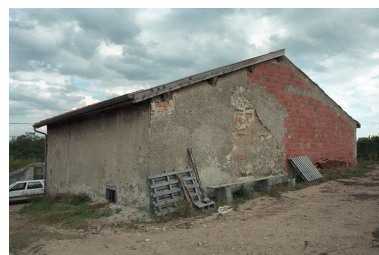
Boën, la Garde-Ouest, parcelle 1986 AI 77. Vue d'ensemble de trois quarts arrière droit. Phot. Thierry Monnet IVR82_20054200164ZE
