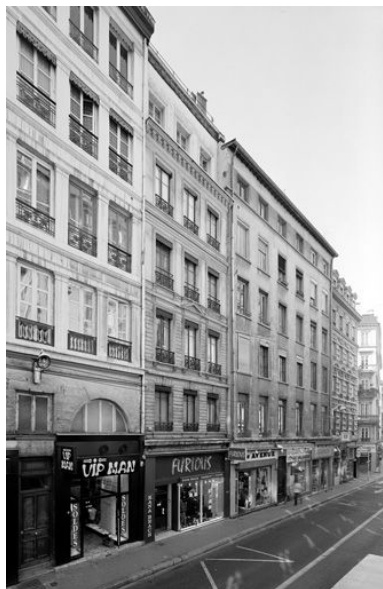
Façade, vue générale Phot. Didier Gourbin IVR82_20056902667V
