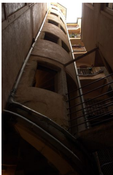
Tour d'escalier Phot. Bernard Ducouret IVR82_20036901181NUCA
