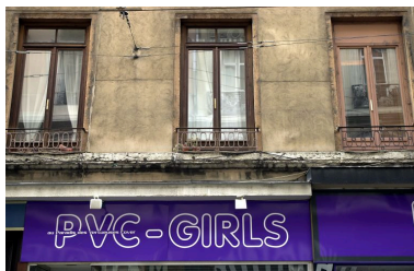
Façade, détail des fenêtres du premier étage Phot. Bernard Ducouret IVR82_20036901183NUCA
