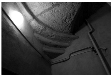
Escalier, console soutenant un angle vu depuis le palier du 2e étage Phot. Bernard Ducouret IVR82_20036901184NUC
