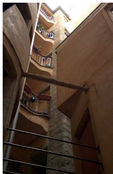
Passage de la tour d'escalier vers le corps en fond de cour et galeries de l'aile gauche Phot. Bernard Ducouret IVR82_20036901182NUCA
