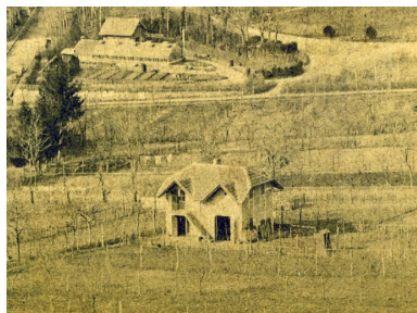
Vue prise du sud Repro. François Fouger IVR82_20097300992NUCB
