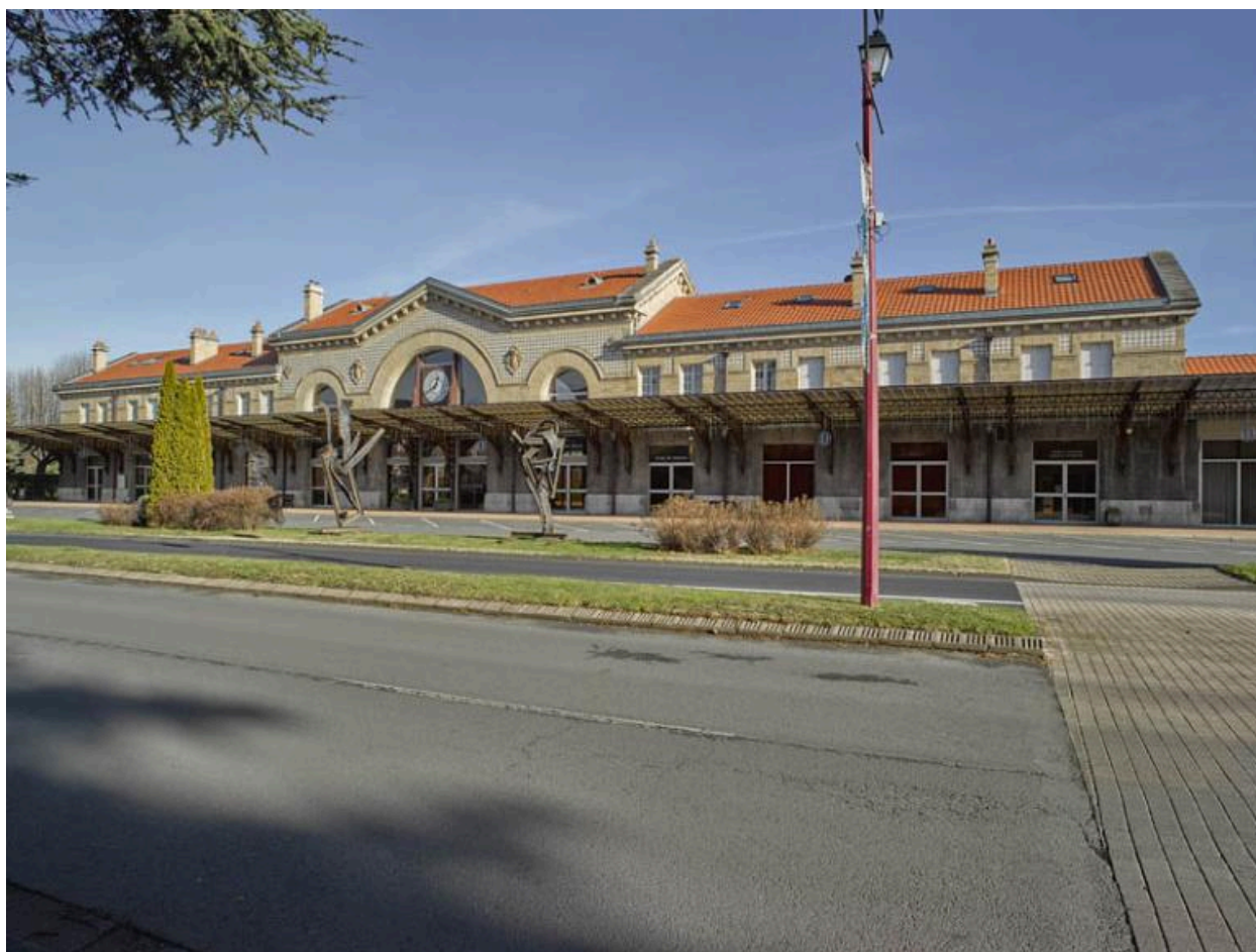
Elévation de l'ancienne gare de Châtel-Guyon, côté cour des voyageurs.
