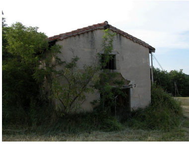
Vue générale. Phot. Thierry Monnet IVR82_20134200745NUCA
