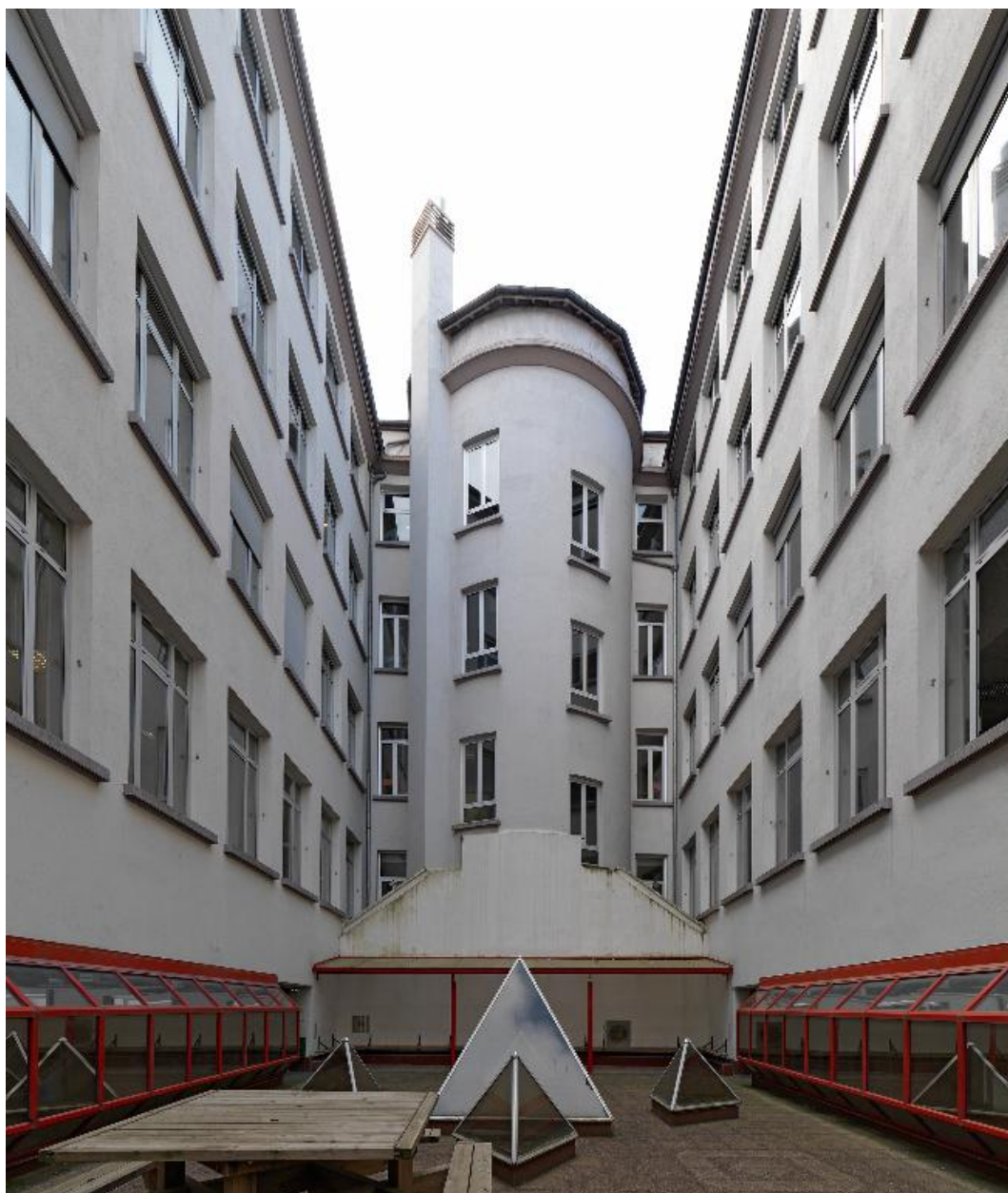
La cour : élévations et tour d'escalier
