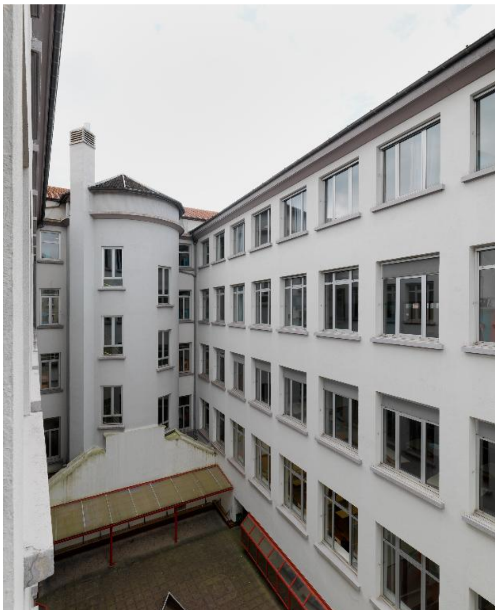
Cour et élévation ouest, depuis le nord
