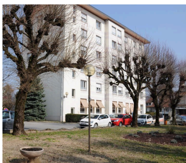
Vue d'ensemble Phot. Denys Harreau IVR82_20147300512NUCA
