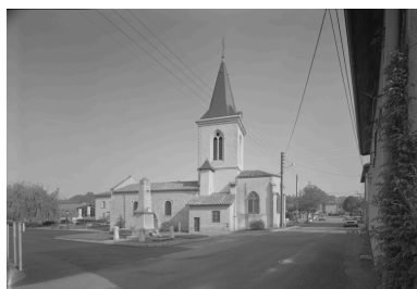
Vue d'ensemble depuis le sud. Phot. Eric Dessert IVR82_19870100115P
