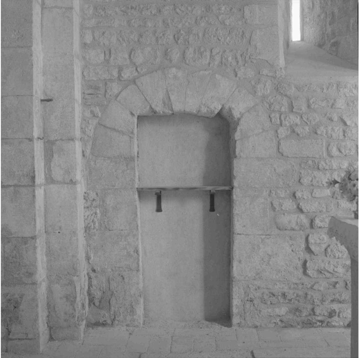
Porte murée (travée de choeur, mur nord).
