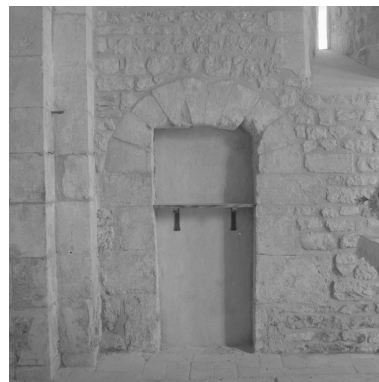
Porte murée (travée de chœur, mur nord). Phot. Eric Dessert IVR82_19870100131X
