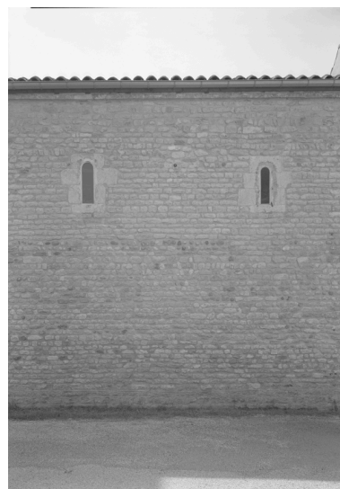
Elévation nord, détail. Phot. Eric Dessert IVR82_19870100126P
