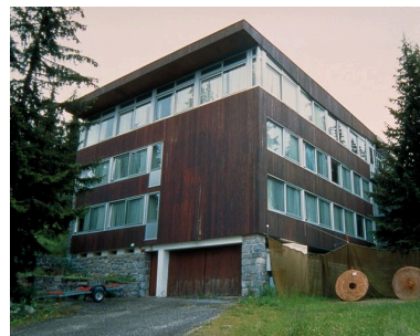
Le Florineige 2. Vue d'ensemble Phot. Jean-François Lyon-Caen IVR82_19987300024ZA
