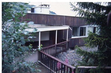
Le Florineige 2. Détail de la terrasse Phot. Jean-François Lyon-Caen IVR82_19987300025ZA
