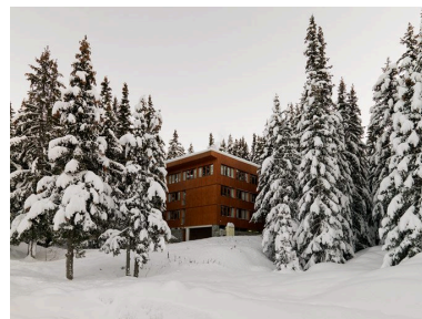
Vue rapprochée Phot. Eric Dessert IVR82_20107304964NUCA
