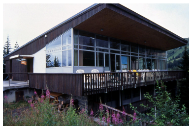
Le Florineige 1. Vue du sud-est Phot. Jean-François Lyon-Caen IVR82_19987300018ZA
