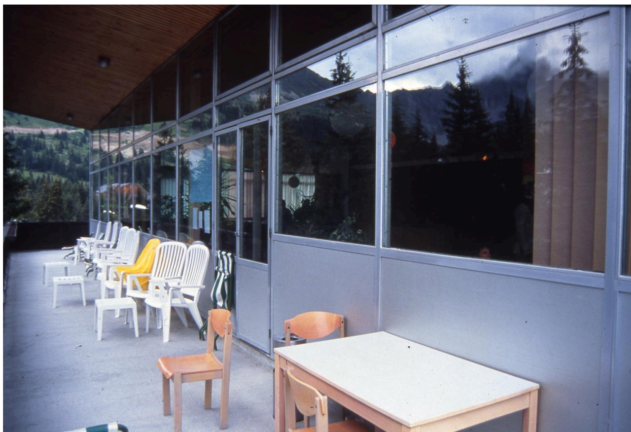
Le Florineige 1. Détail de la coursière sud
