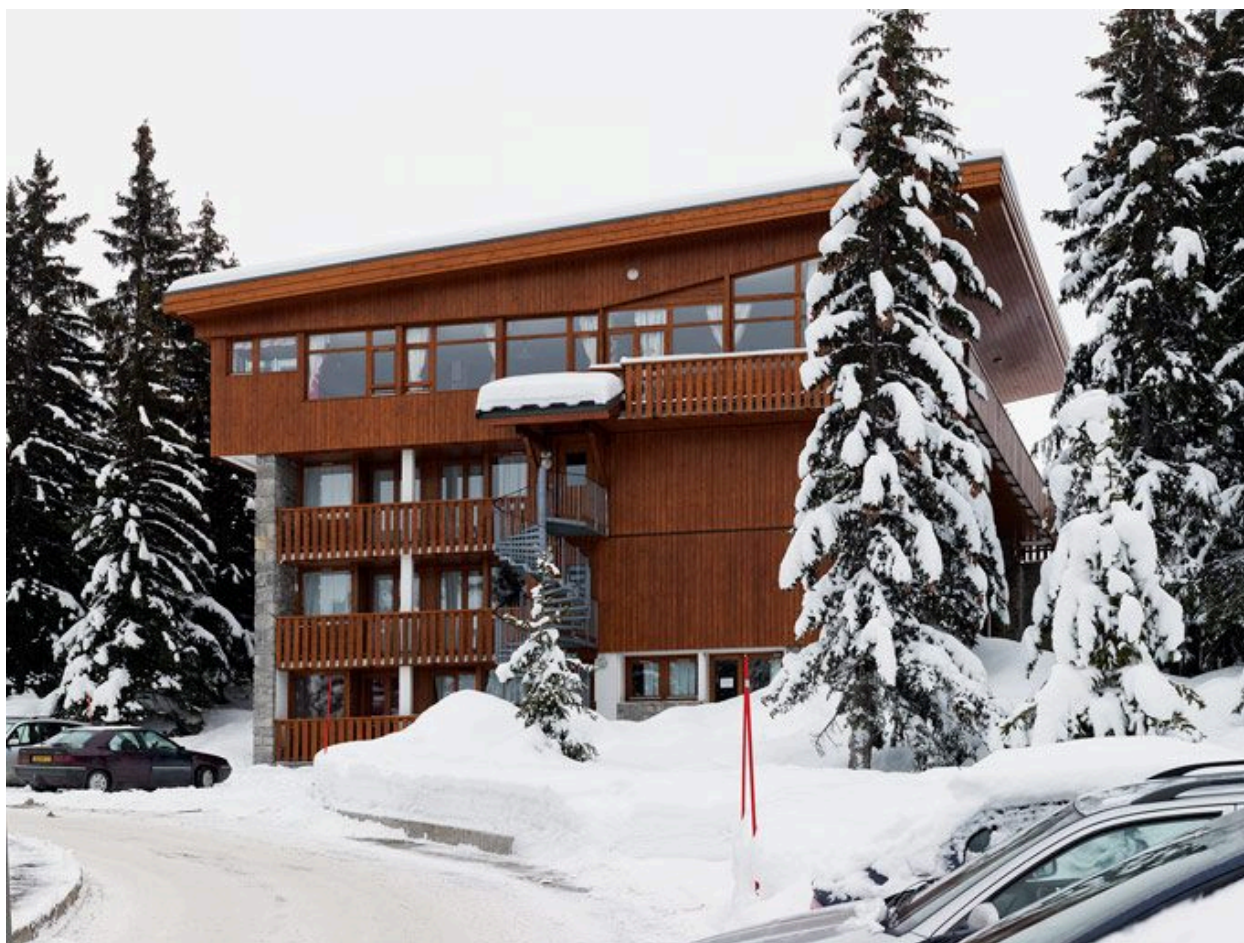
Le Florineige 1. Elévation antérieure
