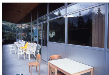
Le Florineige 1. Détail de la coursière sud Phot. Jean-François Lyon-Caen IVR82_19987300021ZA
