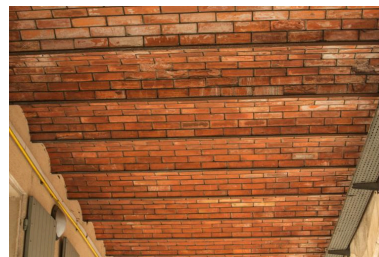
Portique : entrevous en berceaux segmentaires en briques Phot. Pascal Lemaître IVR82_20152600095NUCA
