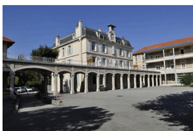
Vue d'ensemble depuis le sud Phot. Catherine Guégan IVR84_20162600003NUCA
