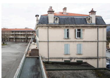
Façade nord et galerie formant balcon au niveau 1 Phot. Pascal Lemaître IVR82_20152600089NUCA
