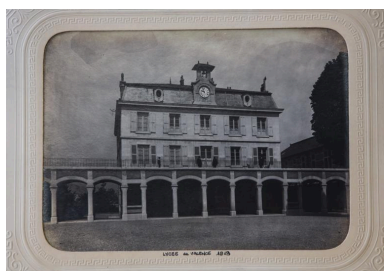
Lycée de Valence : l'administration (photographie ancienne) Repro. Pascal Lemaître IVR82_20152600047NUCB
