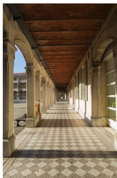
Portique reliant le bâtiment nord au bâtiment sud et le pavillon de l'administration
