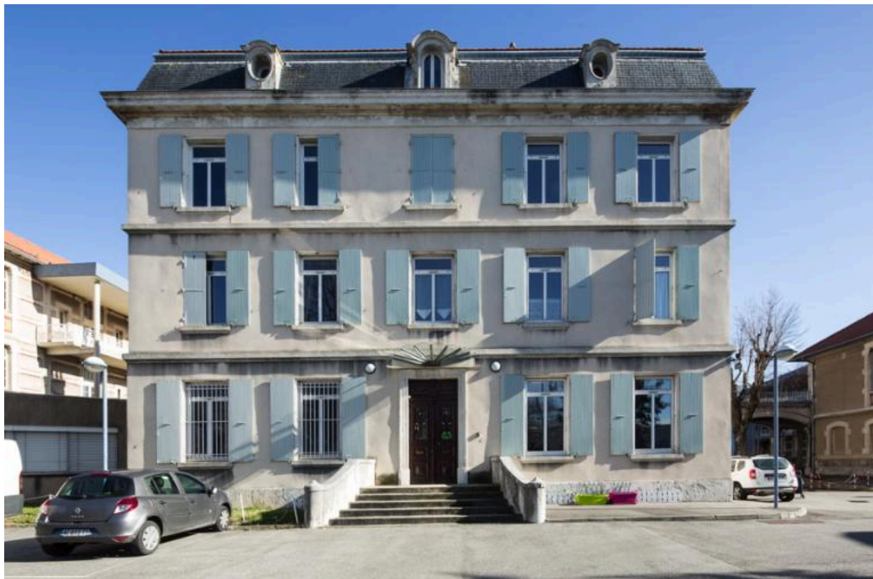
Façade ouest depuis la rue Maurice-Faure
