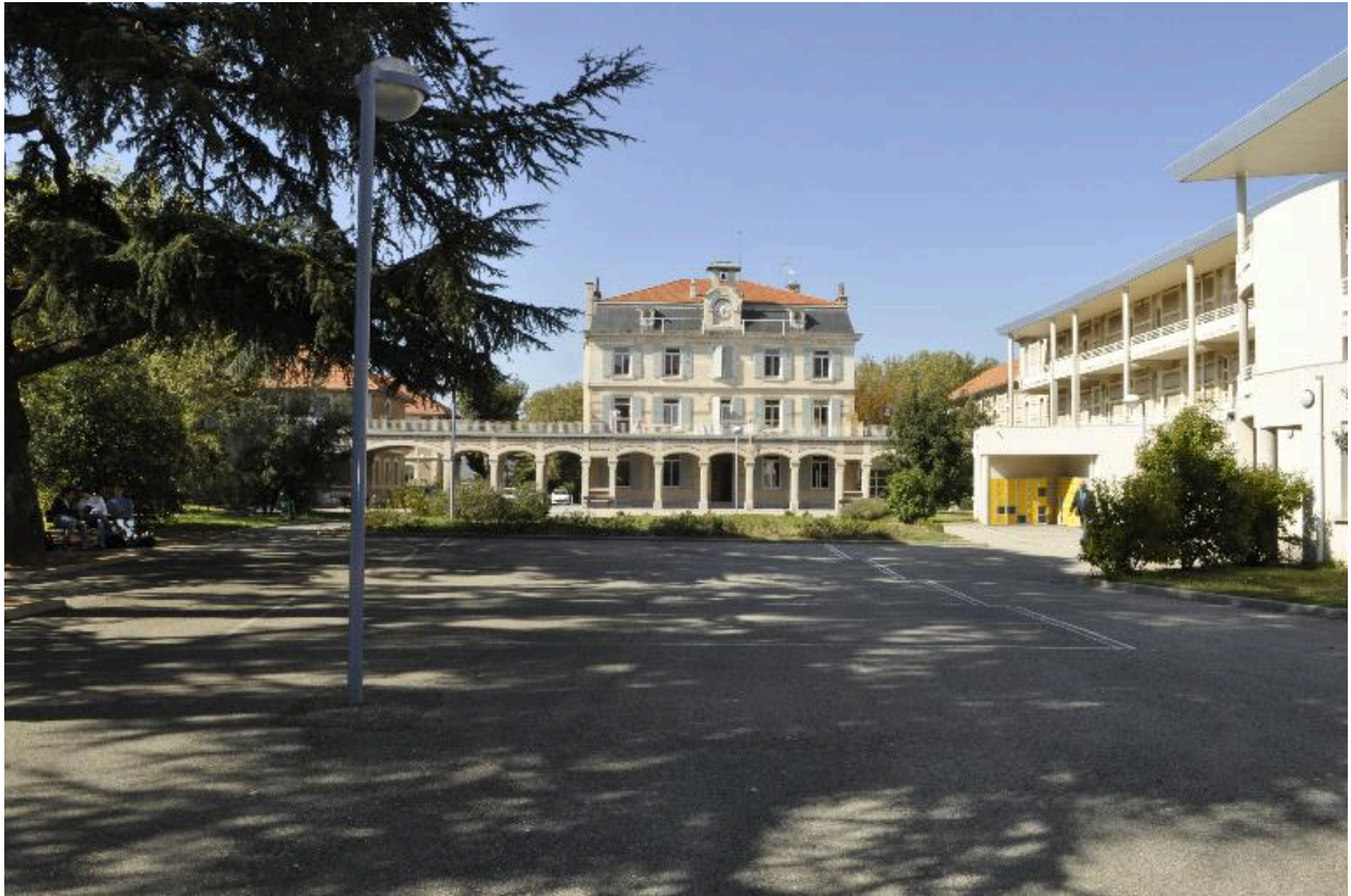
Vue générale depuis l'est
