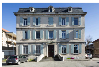
Façade ouest depuis la rue Maurice-Faure Phot. Pascal Lemaître IVR82_20152600086NUCA
