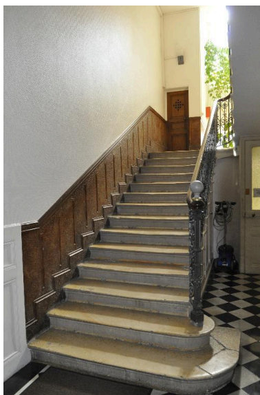
1ère volée de l'escalier Phot. Catherine Guégan IVR84_20162600012NUCA
