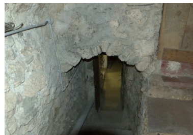
Passage et escalier d'accès à la cave voûtée, au 2e étage de soubassement, dans la partie postérieure de la maison. Phot. Geneviève Jourdan IVR82_20102600591NUCA
