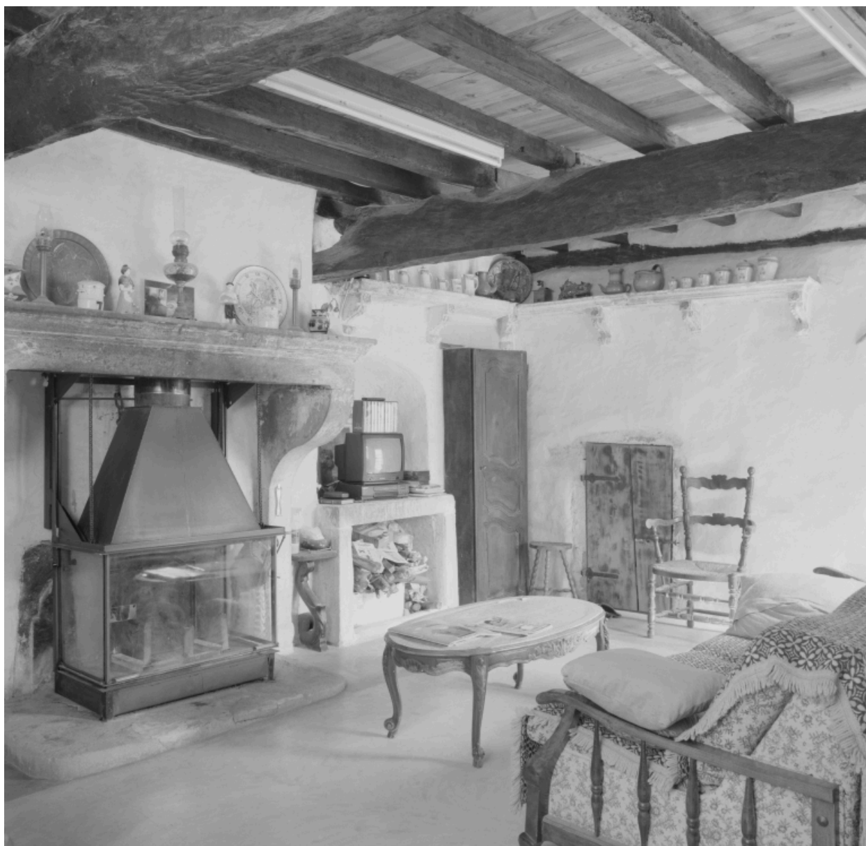
La pièce principale du logis, avec cheminée, potager, placard et étagère en pierre sur consoles.
