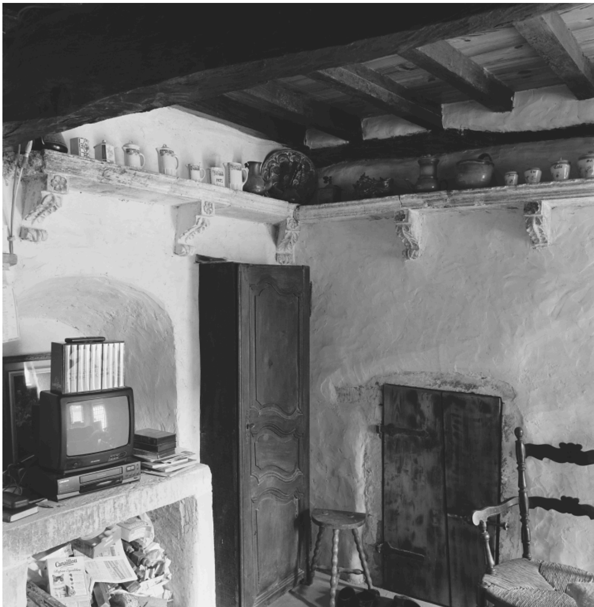
Vue d'ensemble de l'étagère et des consoles en pierre dans la salle du logis.
