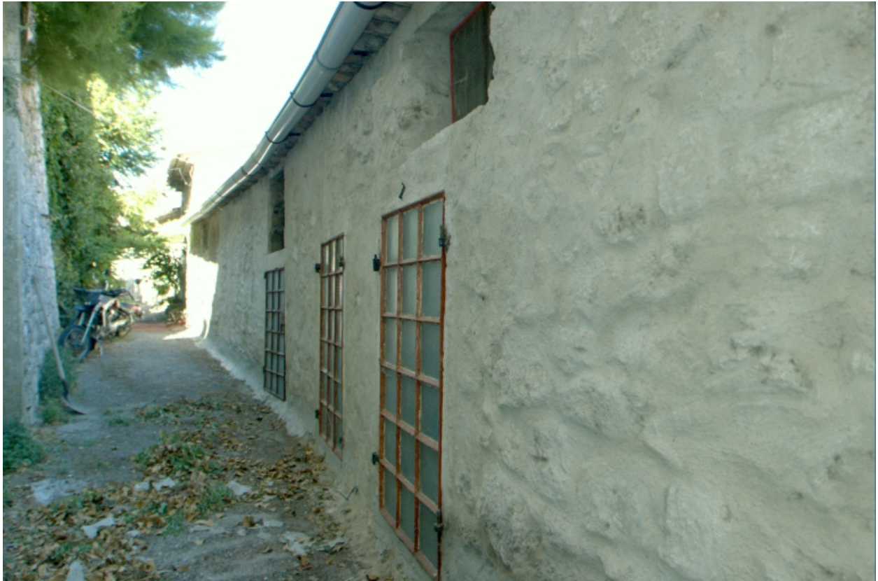
Elévation postérieure sur la rue de l'Androune, vue partielle.
