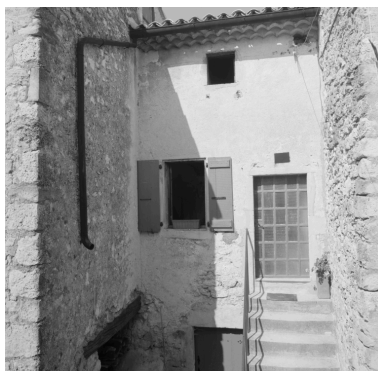
Façade du logis, en retrait sur la Grande rue. Phot. Alain Franchella IVR82_19992600451X
