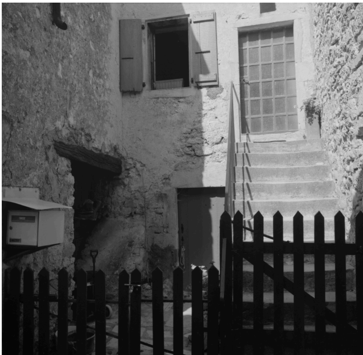
Façade du logis, en retrait sur la Grande rue, vue partielle.
