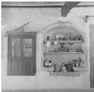
Détail de la salle : évier en pierre et placard. Phot. Alain Franchella IVR82_19992600454X
