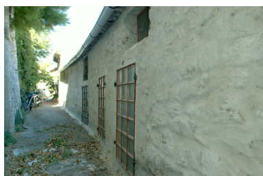
Elévation postérieure sur la rue de l'Androune, vue partielle. Phot. Geneviève Jourdan IVR82_20102600590NUCA
