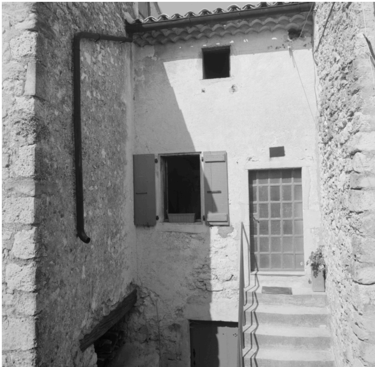
Façade du logis, en retrait sur la Grande rue.
