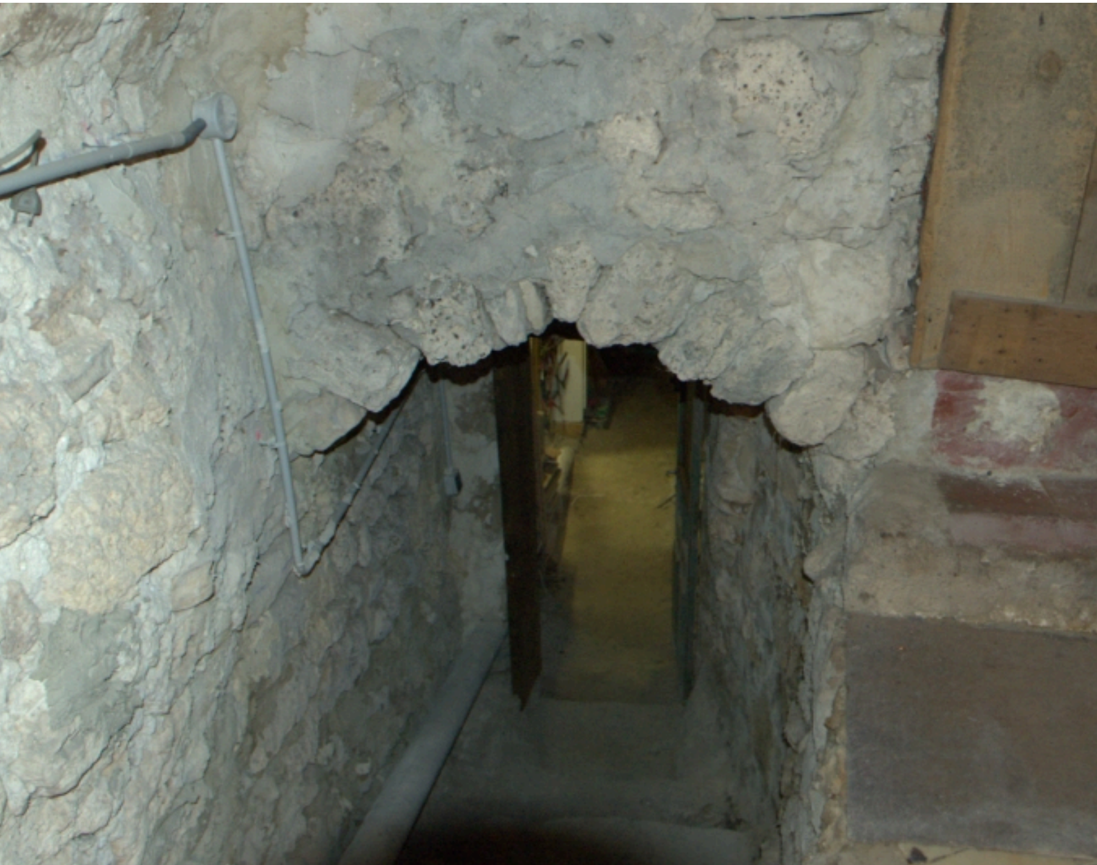
Passage et escalier d'accès à la cave voûtée, au 2e étage de soubassement, dans la partie postérieure de la maison.
