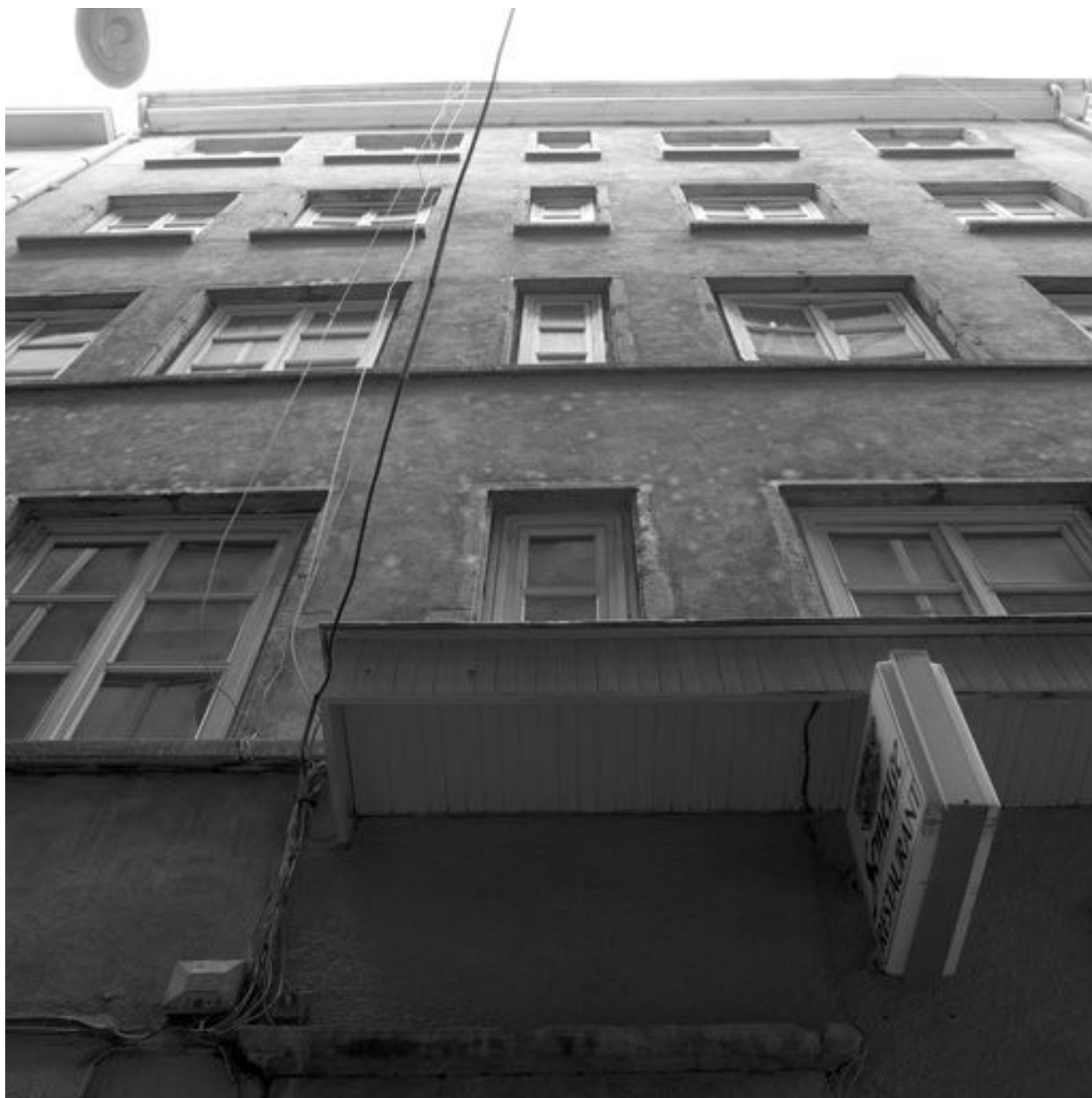
Façade, vue générale par-dessous
