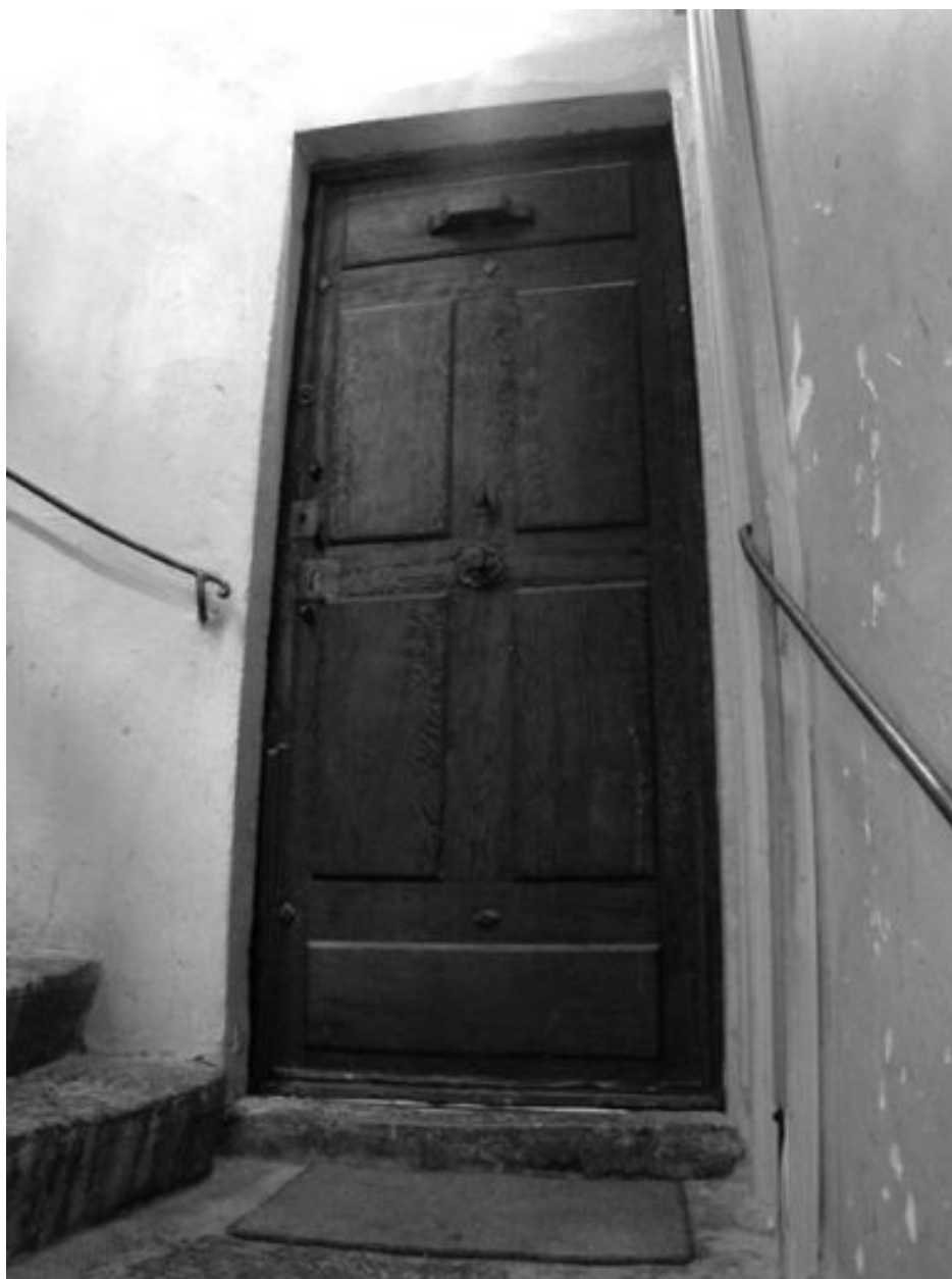
Escalier, porte palière du 3e étage
