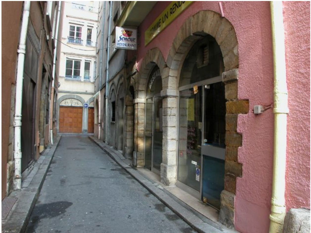
Façade sur rue, rez-de-chaussée
