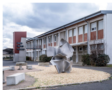
Vue de face, en 2026 Phot. Michel Pérès IVR84_20266300205NUCA
