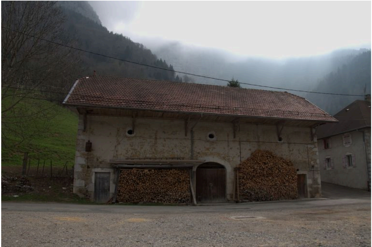
Façade antérieure des anciens magasins de la verrerie
