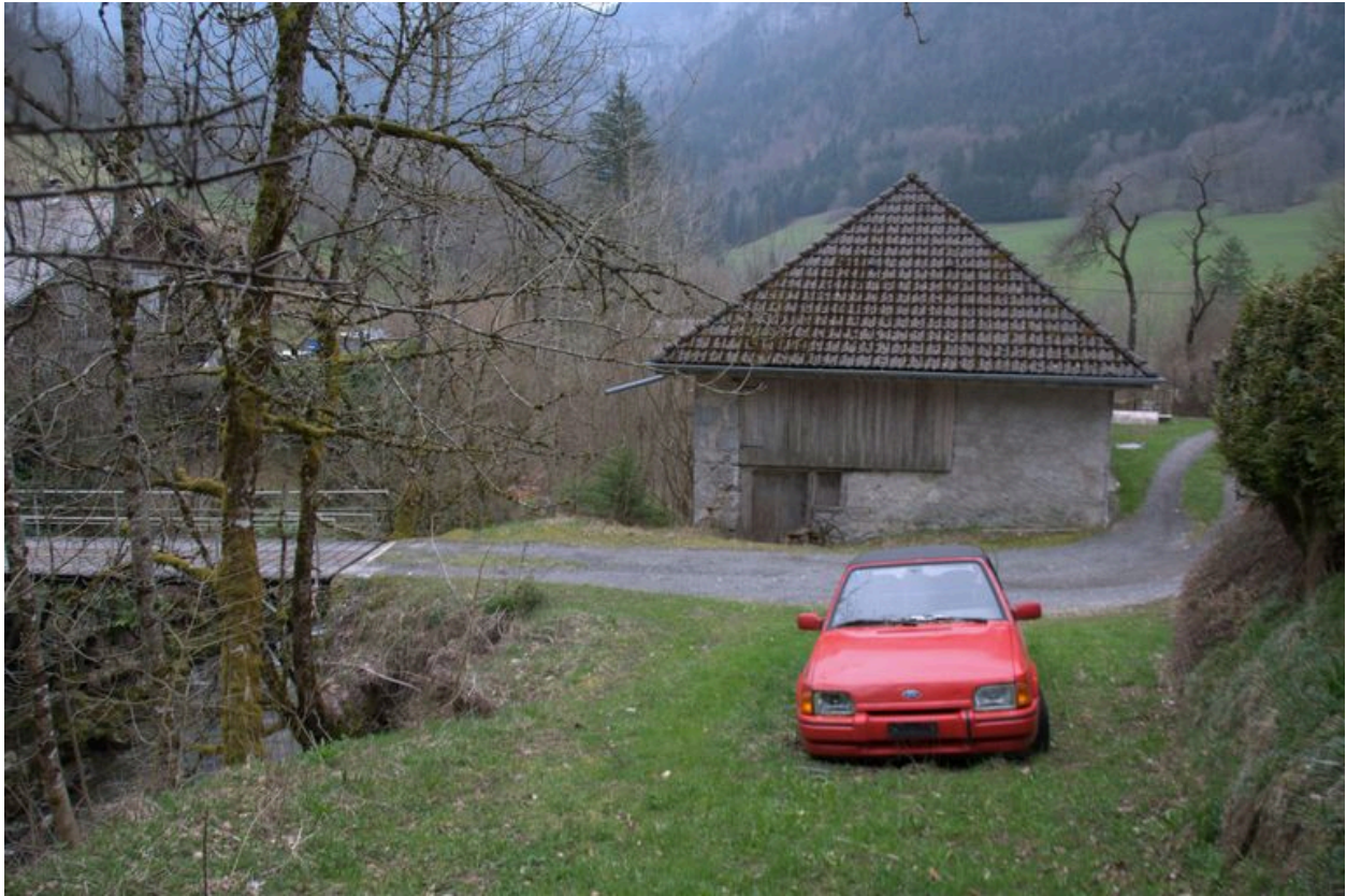
Mur pignon nord de l'ancien moulin
