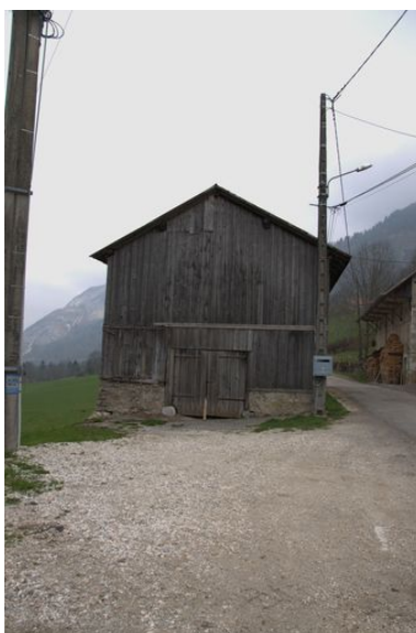
Mur pignon d'une remise Phot. Samir Mahfoudi, Autr. Samir Mahfoudi IVR82_20107403209NUCA
