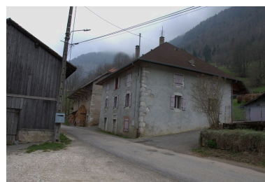
Elévation sud-est d'un logement ouvrier Phot. Samir Mahfoudi, Autr. Samir Mahfoudi IVR82_20107403210NUCA
