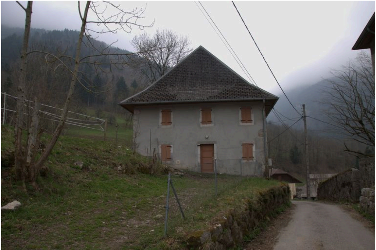
Mur pignon d'une caserne ouvrière
