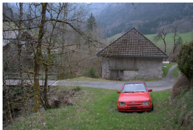
Mur pignon nord de l'ancien moulin Phot. Samir Mahfoudi, Autr. Samir Mahfoudi IVR82_20107403200NUCA
