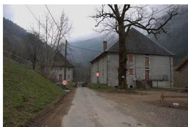
Place du hameau de la Verrerie Phot. Samir Mahfoudi, Autr. Samir Mahfoudi IVR82_20107403208NUCA
