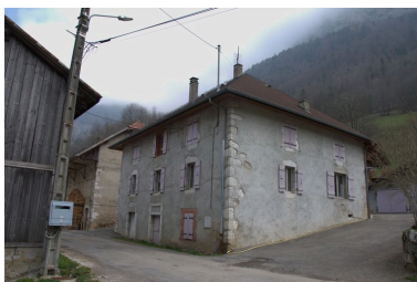
Vue générale Phot. Samir Mahfoudi, Autr. Samir Mahfoudi IVR82_20107403212NUCA
