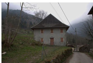
Mur pignon d'une caserne ouvrière Phot. Samir Mahfoudi, Autr. Samir Mahfoudi IVR82_20107403205NUCA
