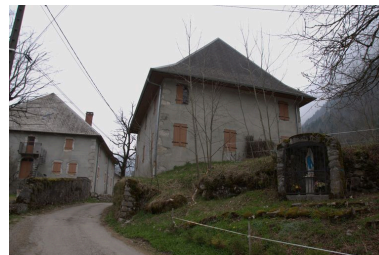
Anciens logements ouvriers Phot. Samir Mahfoudi, Autr. Samir Mahfoudi IVR82_20107403201NUCA
