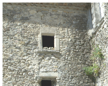
Aile gauche sur cour, 2e niveau, détail : fenêtre à piédroits chanfreinés et à linteau chargé d'une accolade . Phot. Geneviève Jourdan IVR82_20102600546NUCA
