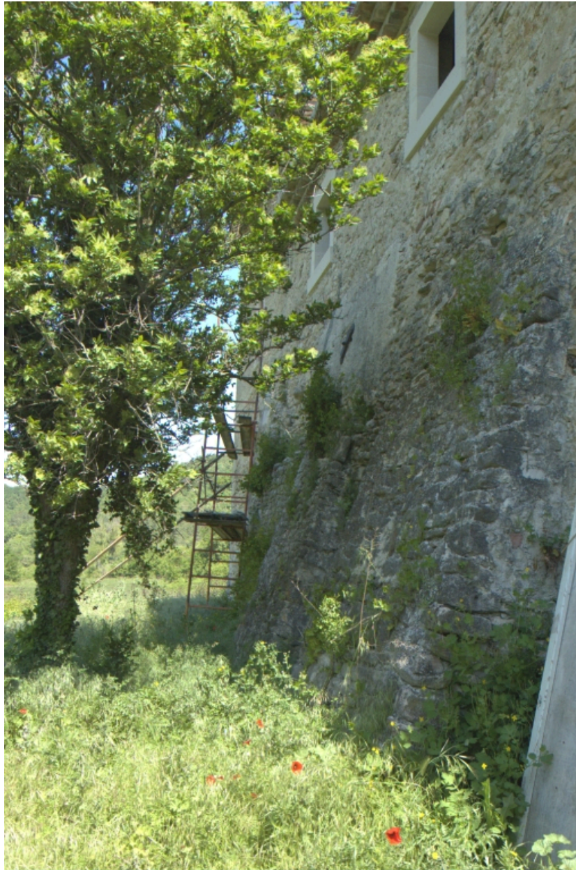
Elévation ouest, détail du fruit à la base du mur.
