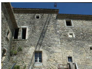
Vue partielle de la façade sur cour, côté gauche, montrant la reprise de construction. Phot. Geneviève Jourdan IVR82_20102600545NUCA
