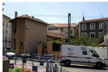
Vue d'ensemble nord Phot. Nadine Halitim-Dubois IVR82_20046902680NUCA
