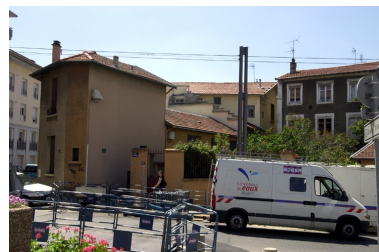
Vue d'ensemble nord Phot. Nadine Halitim-Dubois IVR82_20046902680NUCA
