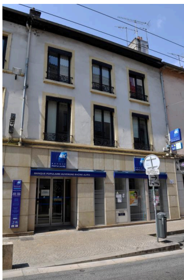
Vue rapprochée du n° 16 Phot. Magali Delavenne IVR84_20186900974NUCA
