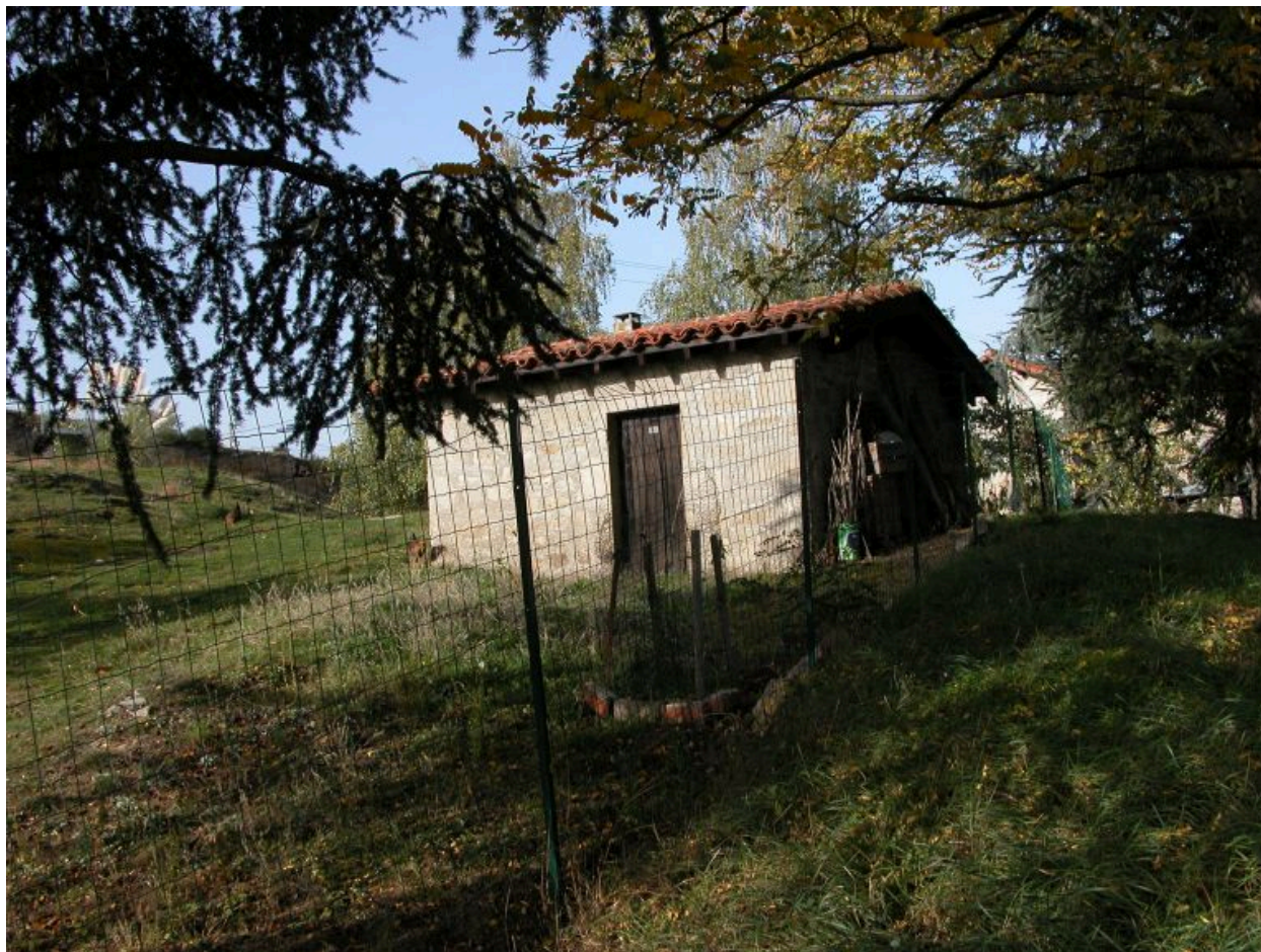
Vue d'ensemble de la forge (AS 239) pour l'exploitation de la carrière.
