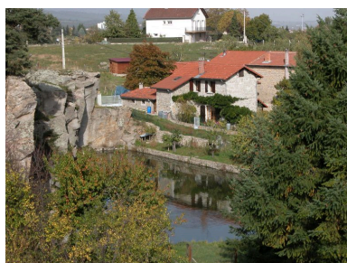
Vue d'ensemble de la ferme depuis le sommet de la carrière. Phot. Thierry Monnet IVR82_20134203223NUCA
