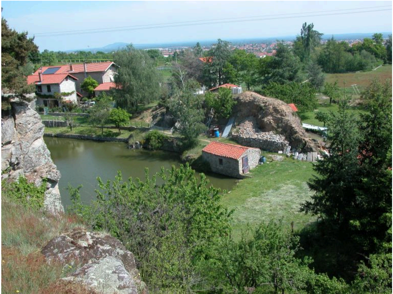
Vue d'ensemble des bâtiments de la ferme et de la pompe.
