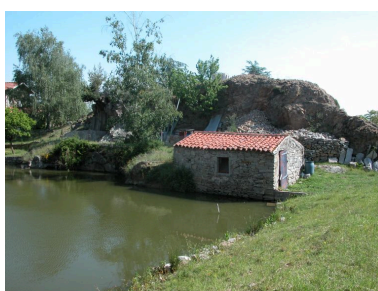
Vue d'ensemble de la pompe (1986 AS 241). Phot. Thierry Monnet IVR82_20134203237NUCA
