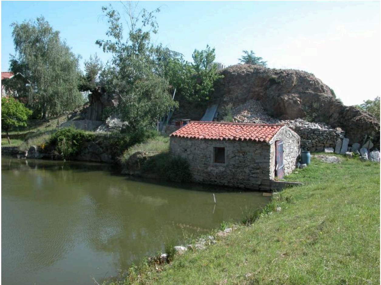
Vue d'ensemble de la pompe (1986 AS 241).
