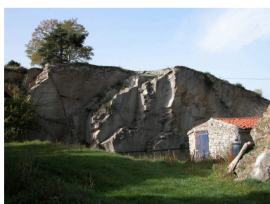
Vue d'ensemble du bâtiment abritant la pompe (AS 241). Phot. Thierry Monnet IVR82_20134203229NUCA
