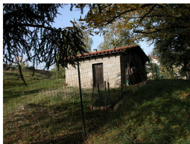
Vue d'ensemble de la forge (AS 239) pour l'exploitation de la carrière. Phot. Thierry Monnet IVR82_20134203224NUCA
