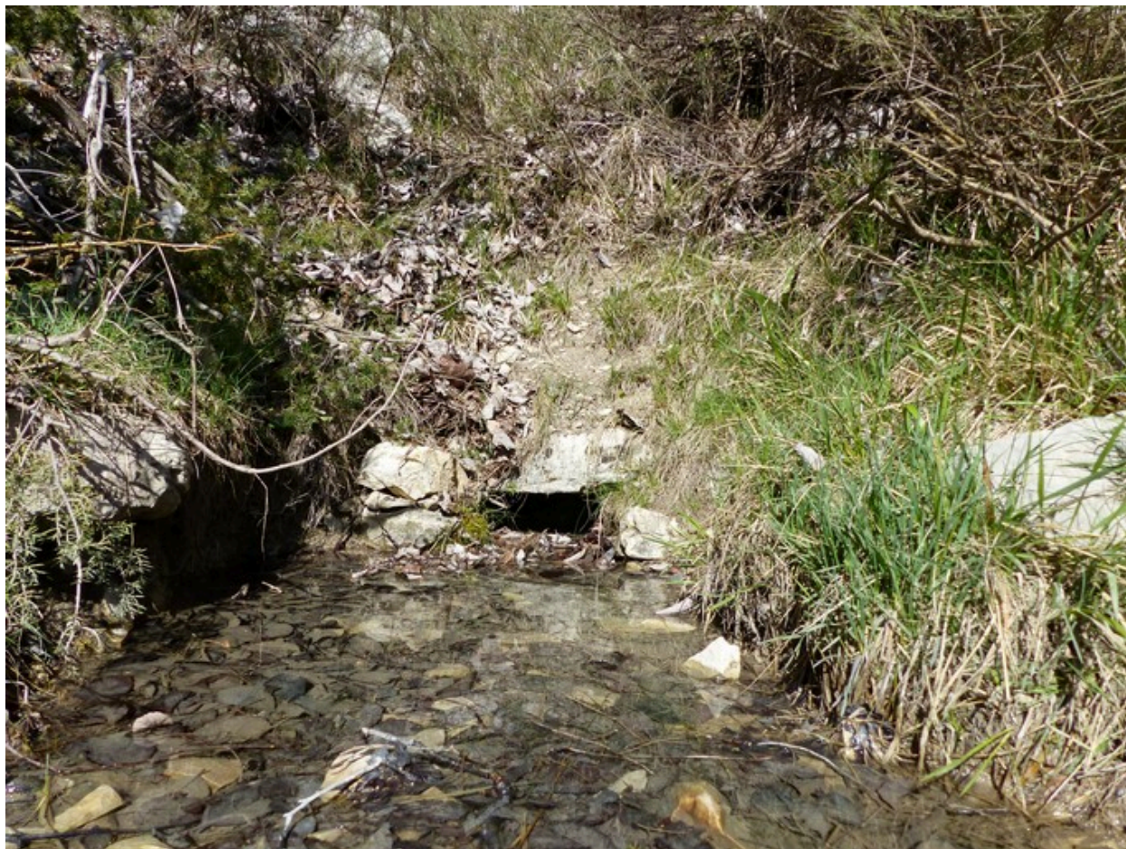
Fontaine de Peyméan. Bassin et arrivée de la mine de captage.
