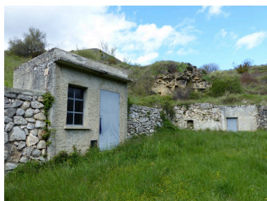
Fontaine et captage du Génisseau. Phot. Alexeï Laurent IVR84_20162601090NUCA
