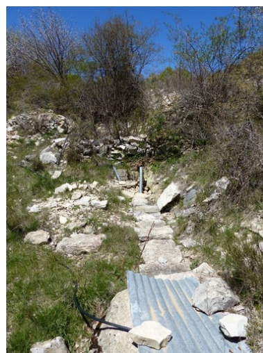
Fontaine basse de Chanaux. Vue d'ensemble prise du sud. Phot. Alexeï Laurent IVR84_20162601095NUCA
