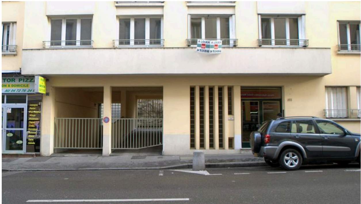
Détail du rez-de-chaussée
