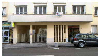
Détail du rez-de-chaussée Phot. Maryannick Chalabi IVR82_20116904088NUCA
