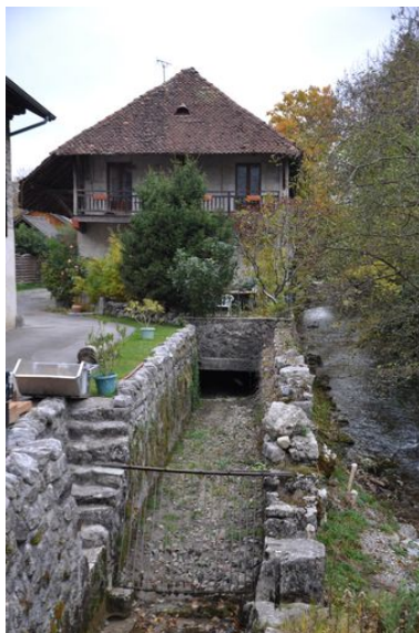
Canal d'amenée donnant sur le mur pignon sud de la scierie Phot. Samir Mahfoudi, Autr. Samir Mahfoudi IVR82_20117401298NUCA
