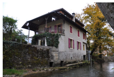
Encoches du canal de fuite percées dans la digue Phot. Samir Mahfoudi, Autr. Samir Mahfoudi IVR82_20117401302NUCA
