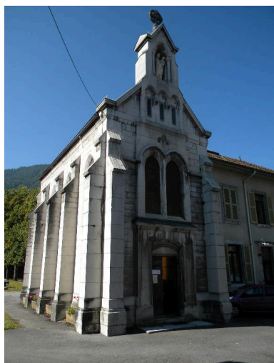
Vue d'ensemble. Phot. Jérôme Daviet IVR82_20147400499NUCA
