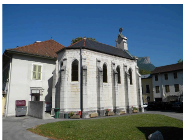
Vue de la façade latérale et du chevet. Phot. Jérôme Daviet IVR82_20147400500NUCA
