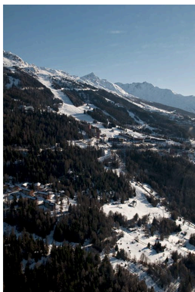
Vue aérienne. La ligne du funiculaire Arc-en-Ciel depuis le nord-est Phot. Eric Dessert IVR82_20117302644NUCA
