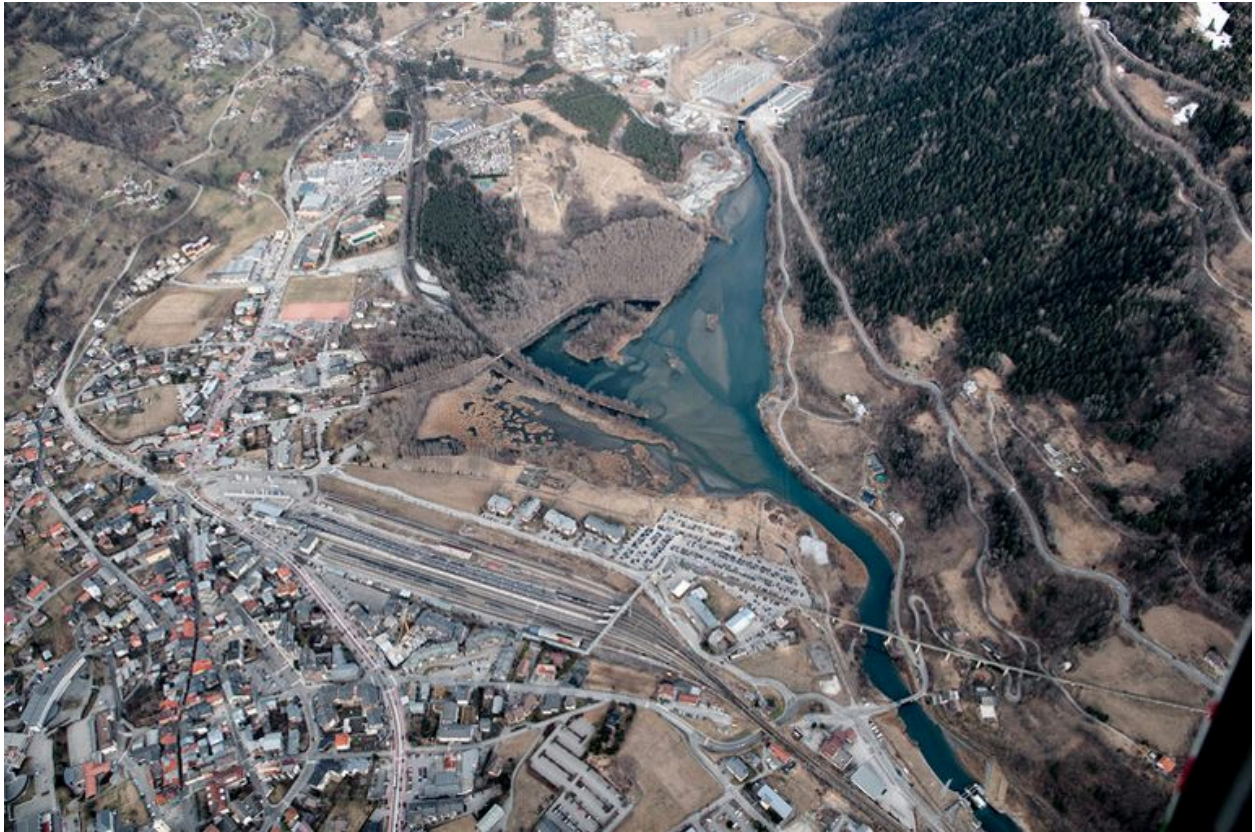
Vue aérienne verticale de la gare de Bourg-Saint-Maurice
