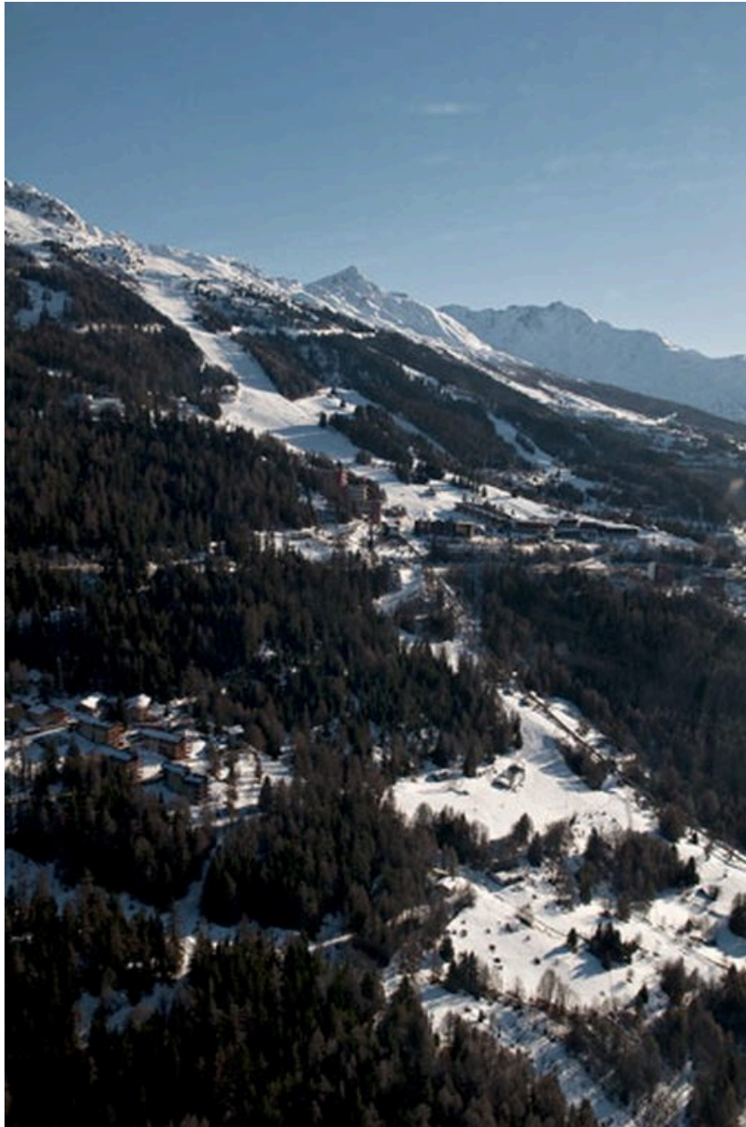
Vue aérienne. La ligne du funiculaire Arc-en-Ciel depuis le nord-est
