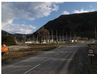
Le poste de transformation électrique et les conduites forcées de la centrale hydroélectrique de Malgovert Phot. Eric Dessert IVR82_20107304940NUCA
