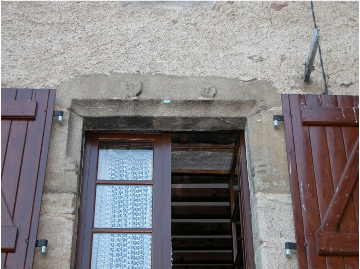
Détail de la fenêtre du 16e siècle en remploi.
