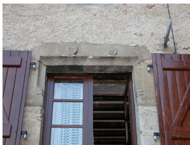
Détail de la fenêtre du 16e siècle en remploi. Phot. Thierry Monnet IVR82_20124201115NUCA
