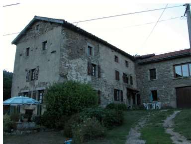
Vue générale. Phot. Thierry Monnet IVR82_20124201116NUCA
