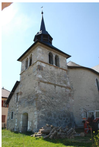
Clocher et sacristie, vus du nord-est. Phot. Thierry Monnet IVR84_20197400736NUCA
