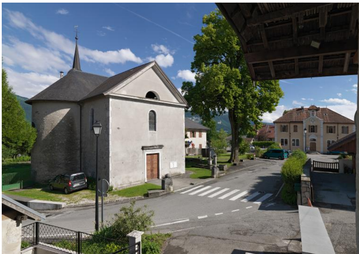
Vue générale depuis le nord-ouest.
