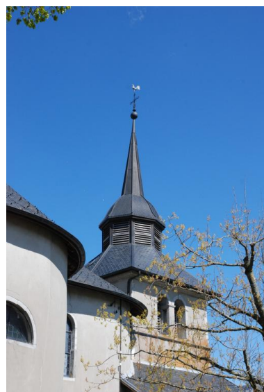
Détail des parties hautes du clocher. Phot. Thierry Monnet IVR84_20197400735NUCA
