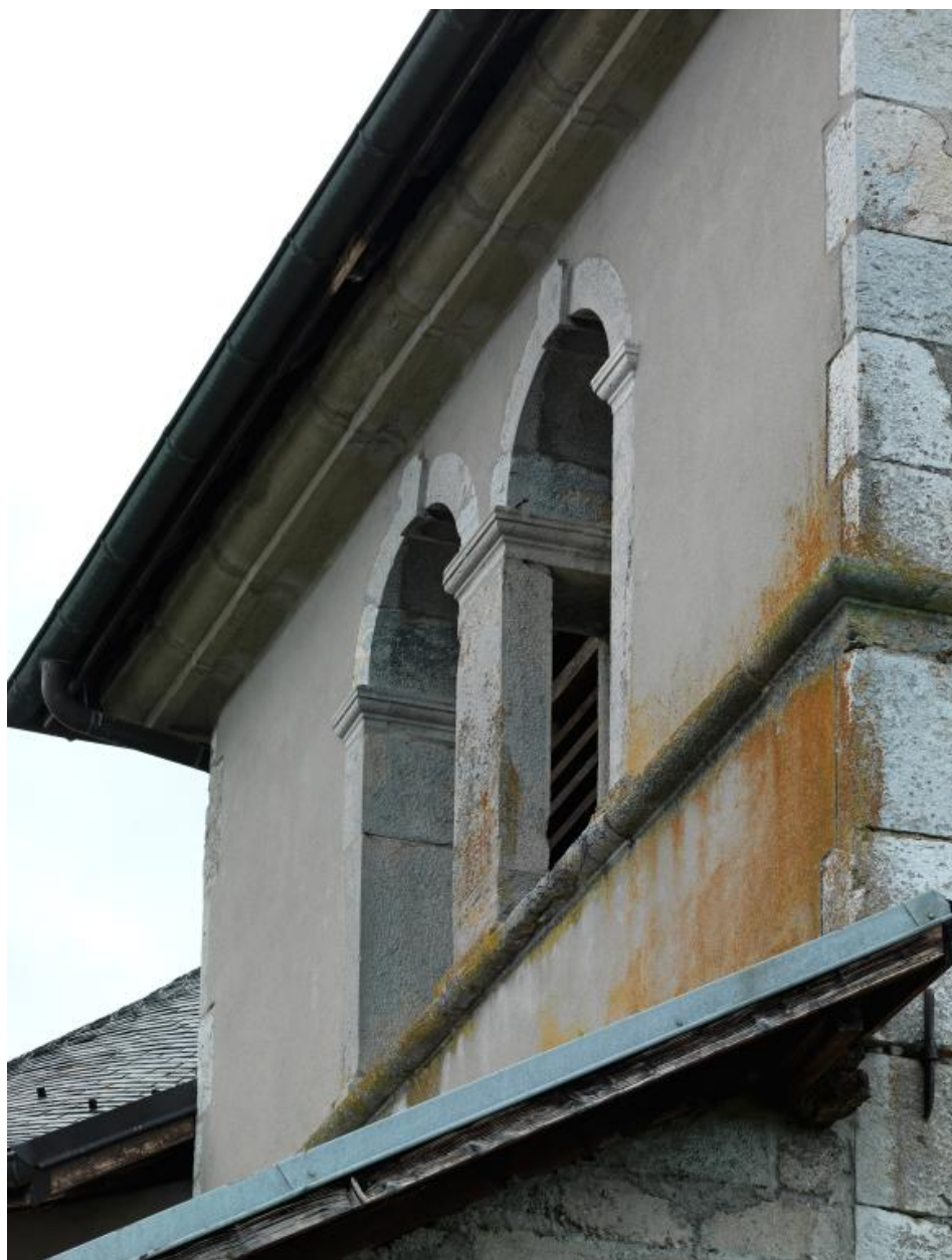
Détail des baies du clocher.
