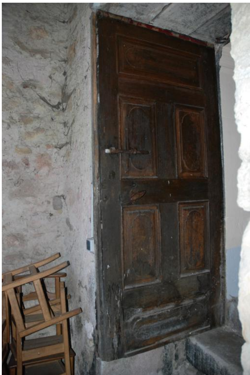
Détail du vantail de la porte entre le clocher et l'abside (côté abside).
