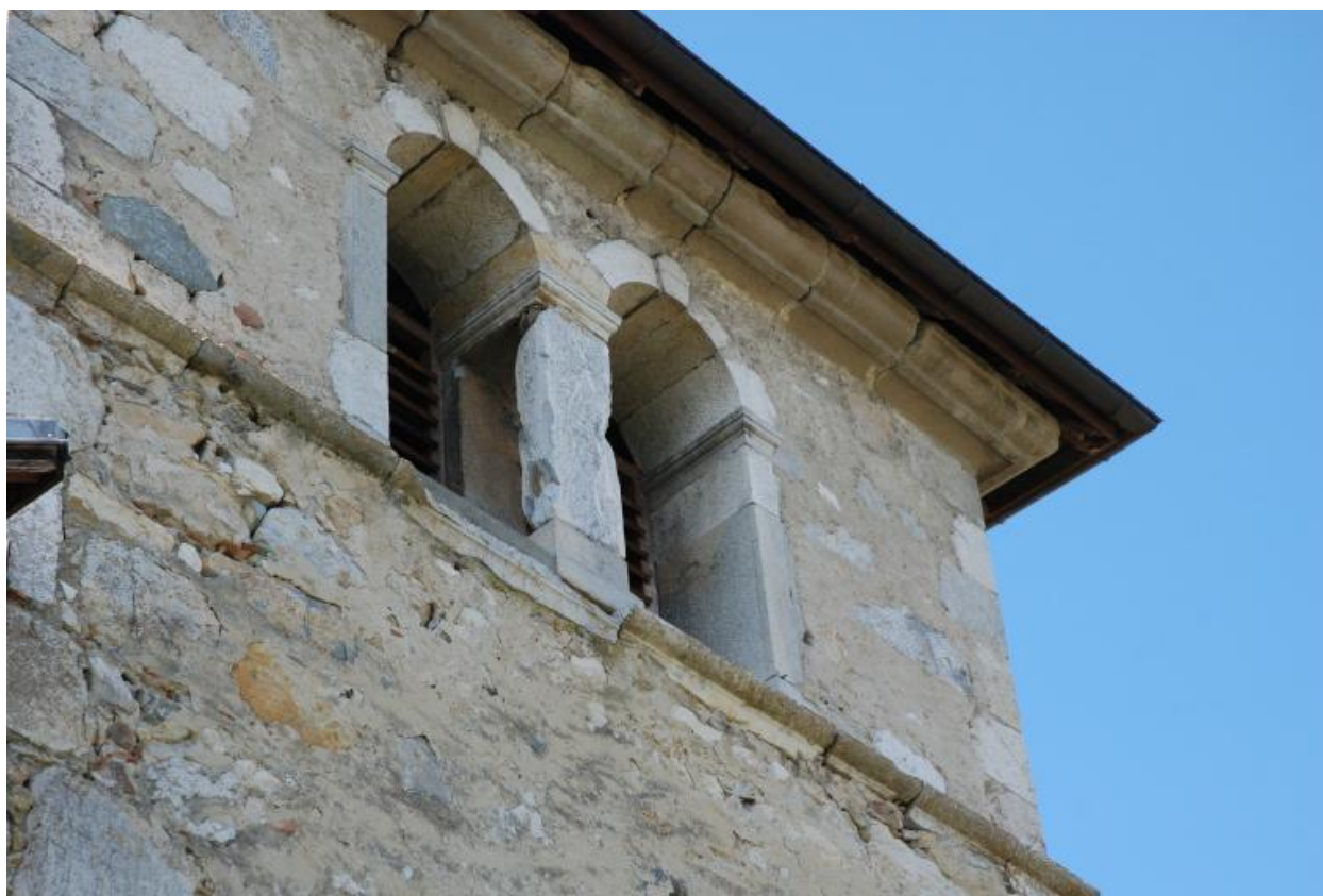
Détail des baies du clocher.
