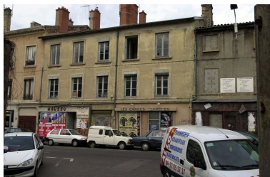
Façade sur rue du n° 149, bâtiment existant en 2001 Phot. Bernard Ducouret IVR82_20016900073NUCA
