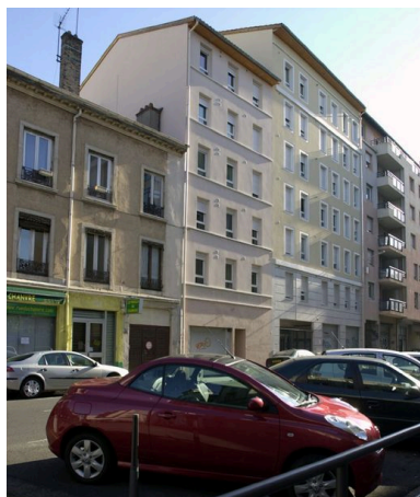
Elévation antérieure depuis le sud-ouest Phot. Maryannick Chalabi IVR82_20096901348NUCA
