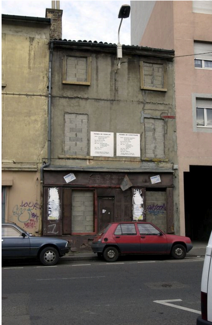
Façade du n° 151, bâtiment existant en 2001
