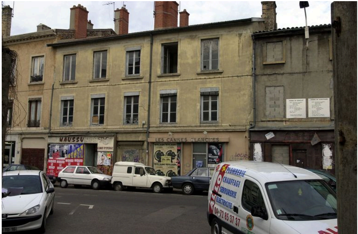
Façade sur rue du n° 149, bâtiment existant en 2001
