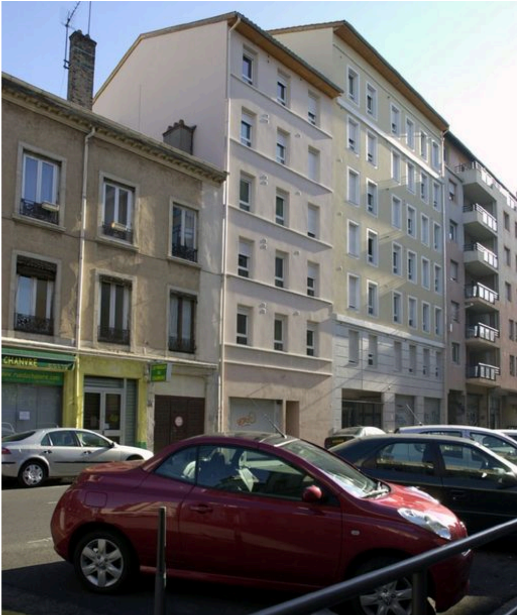
Elévation antérieure depuis le sud-ouest
