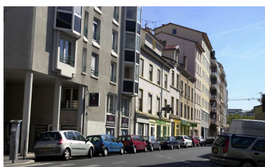
Vue de situation Phot. Maryannick Chalabi IVR82_20096901350NUCA
