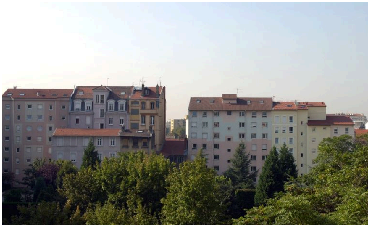
Elévation postérieure, depuis le nord
