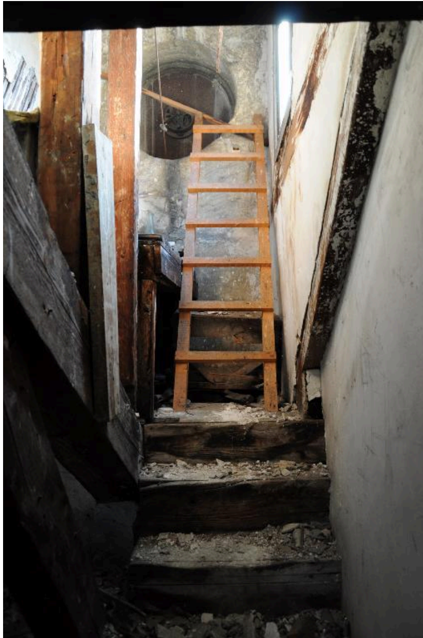
Accès à l'horloge depuis les combles
