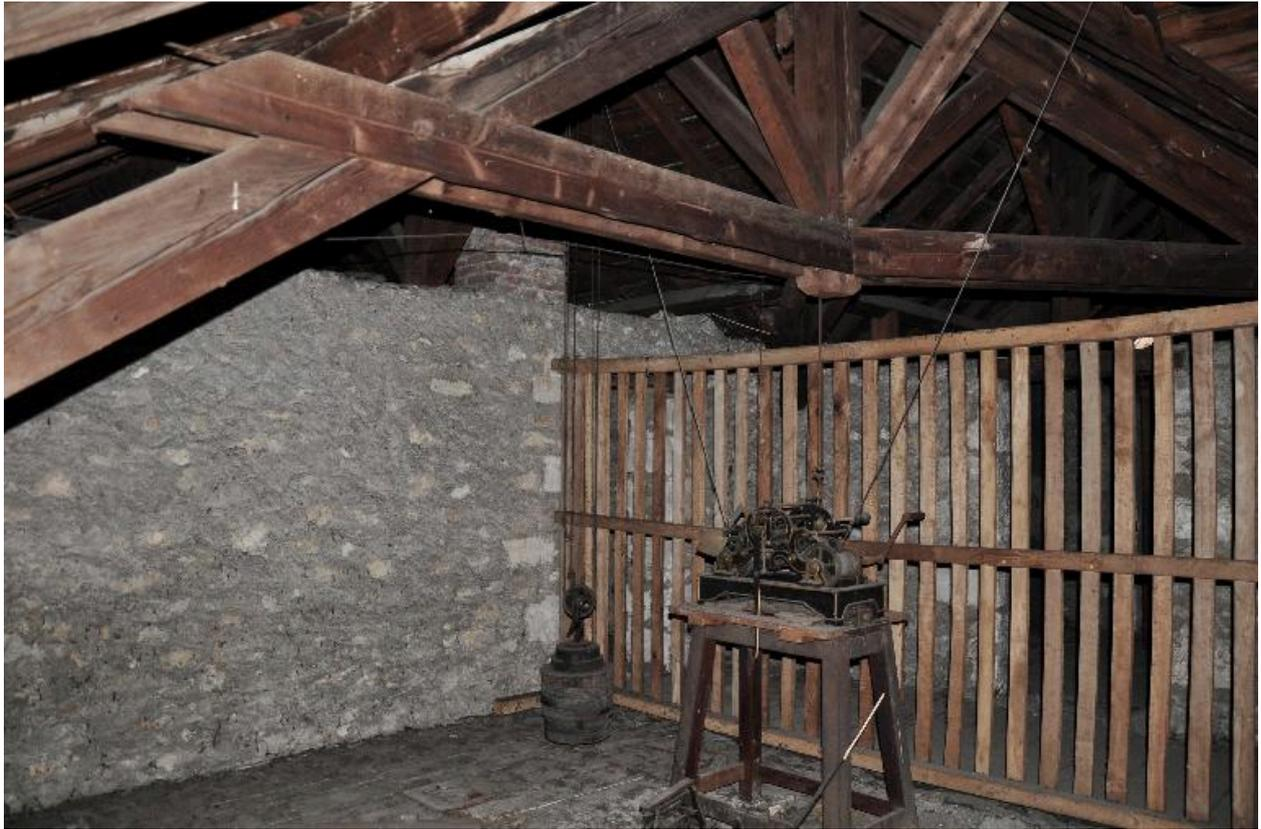
Mécanisme de l'horloge dans les combles
