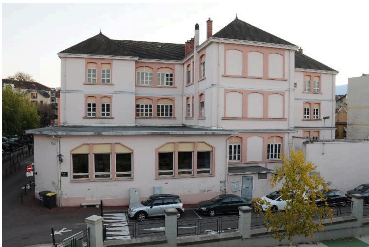
Vue d'ensemble : façades postérieures
