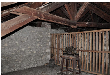
Mécanisme de l'horloge dans les combles Phot. Denys Harreau IVR82_20157300057NUCA
