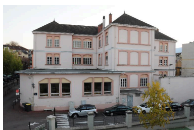
Vue d'ensemble : façades postérieures Phot. Denys Harreau IVR82_20157300031NUCA
