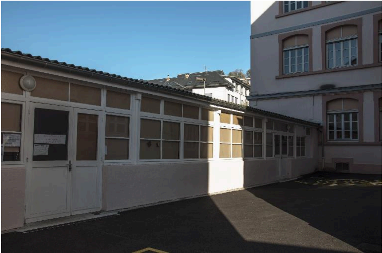
Corps de bâtiment, angle nord-ouest
