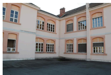
Baies des 1er et 2nd étages Phot. Denys Harreau IVR82_20157300053NUCA
