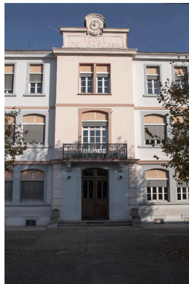
Travée centrale, façade principale Phot. Denys Harreau IVR82_20157300070NUCA
