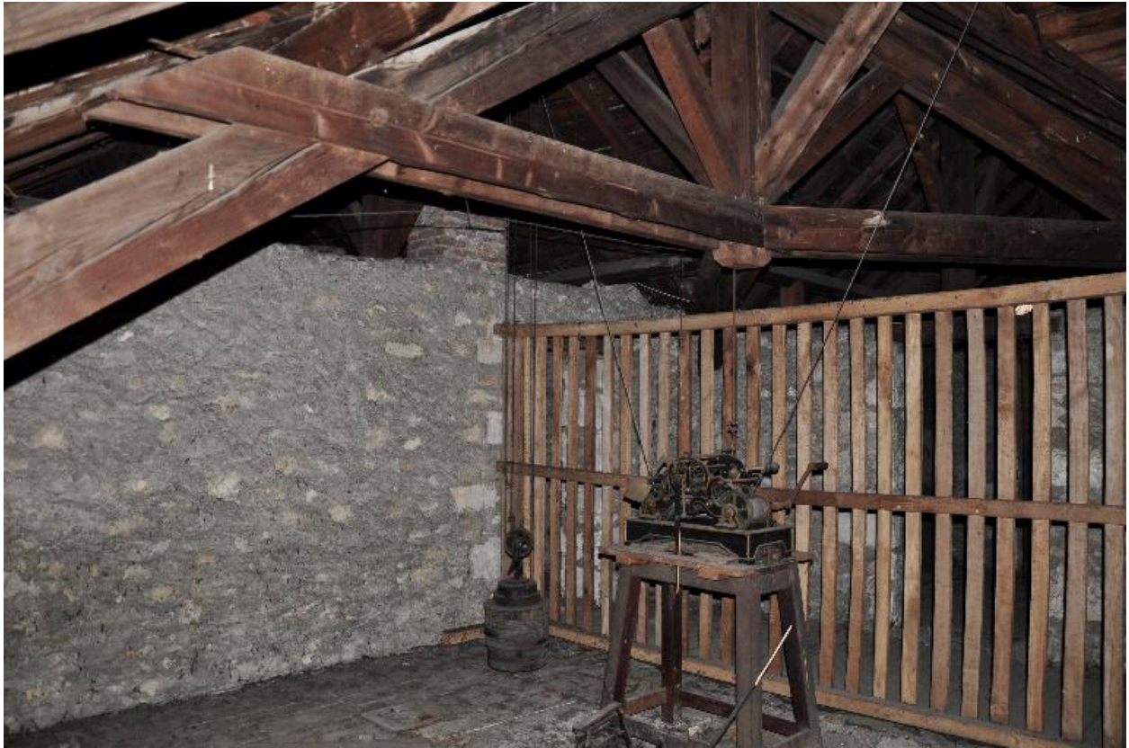
Mécanisme de l'horloge dans les combles
