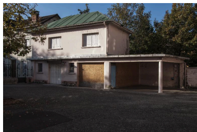
Ancienne loge de concierge Phot. Denys Harreau IVR82_20157300073NUCA
