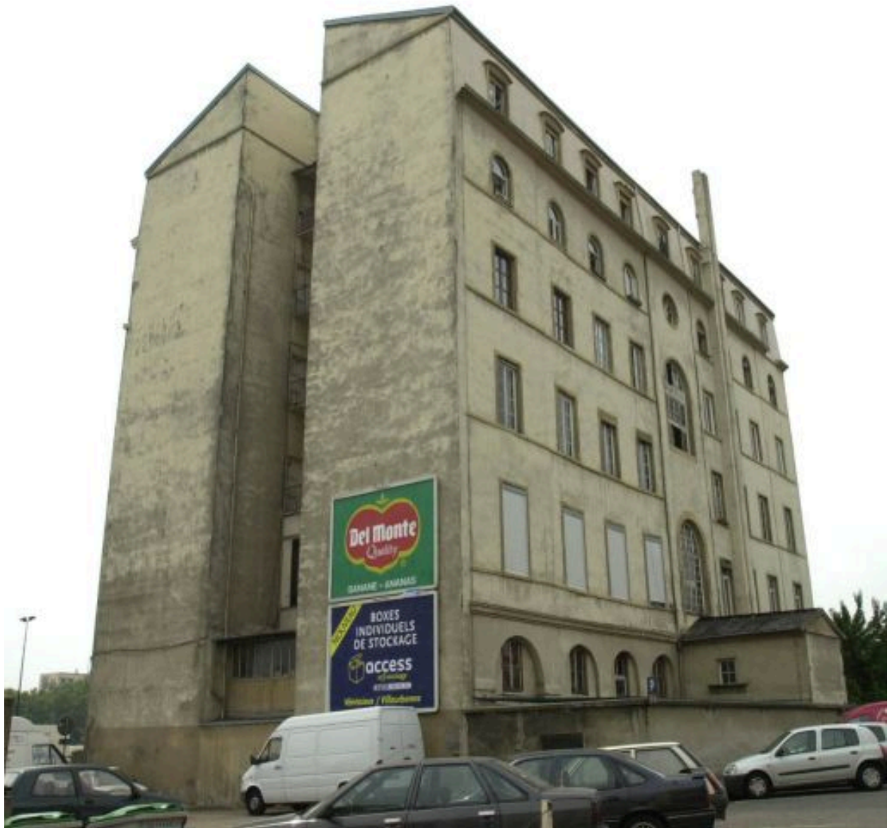
Vue d'ensemble depuis le nord-ouest, l'élévation postérieure et le pignon nord
