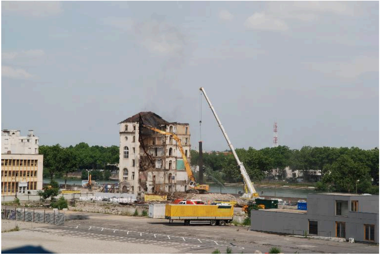
L'immeuble en cours de démolition
