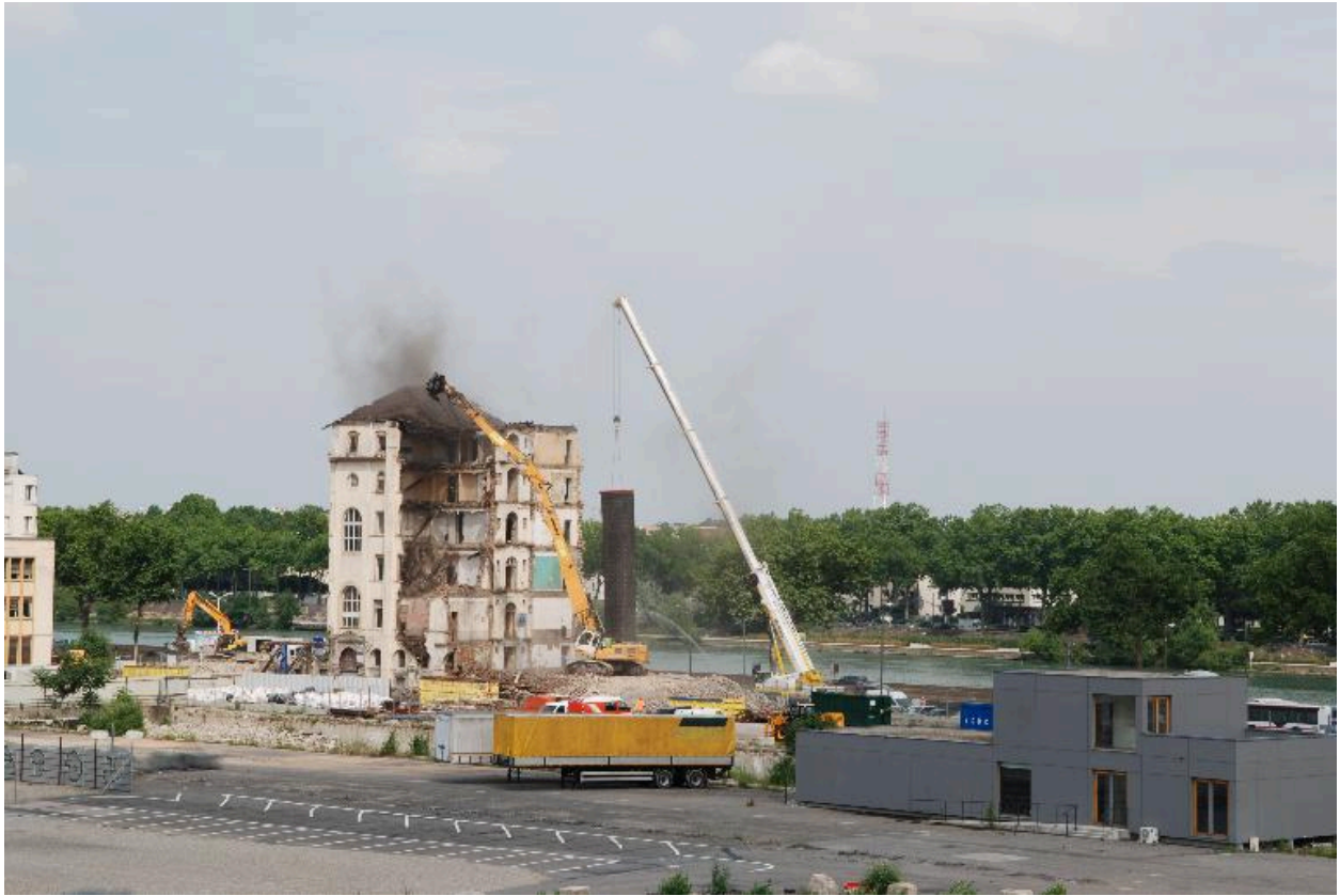
L'immeuble en cours de démolition
