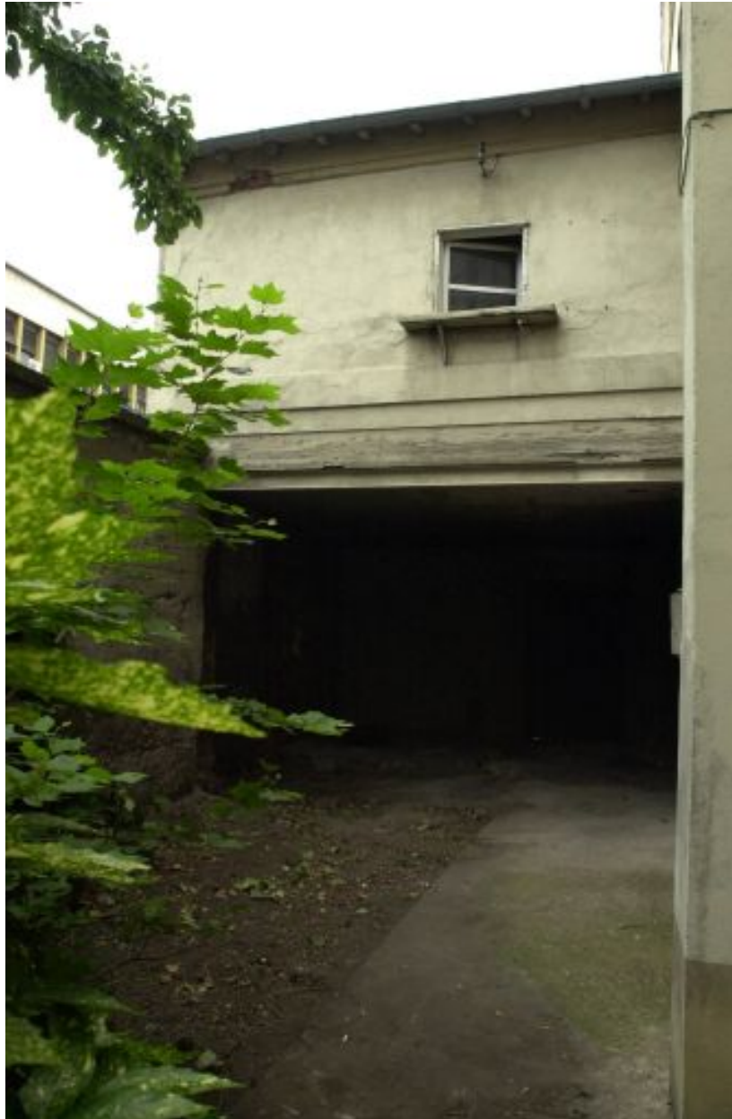
Vue de la loge de concierge construite contre l'élévation postérieure
