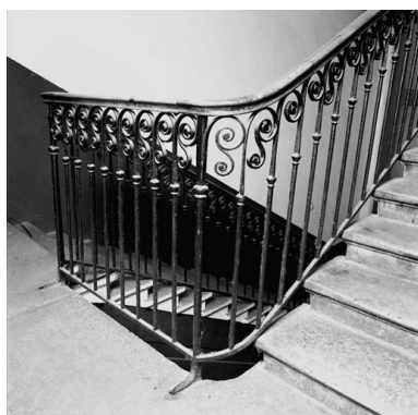
Détail de la rampe d'escalier Phot. Jean-Marie Refflé IVR82_20026900096X
