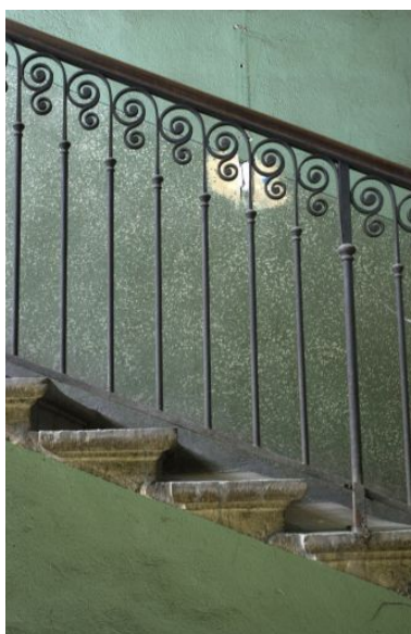
Détail de la rampe de l'escalier
