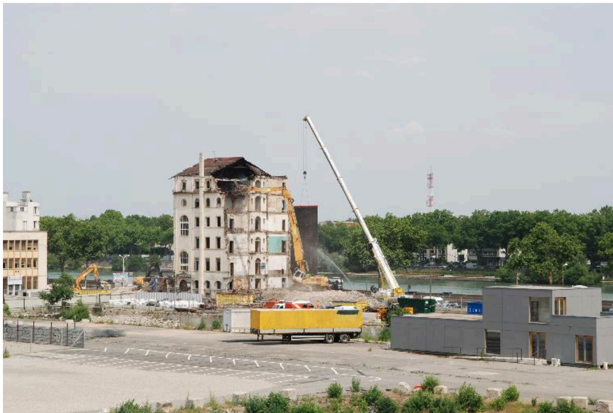
L'immeuble en cours de démolition
