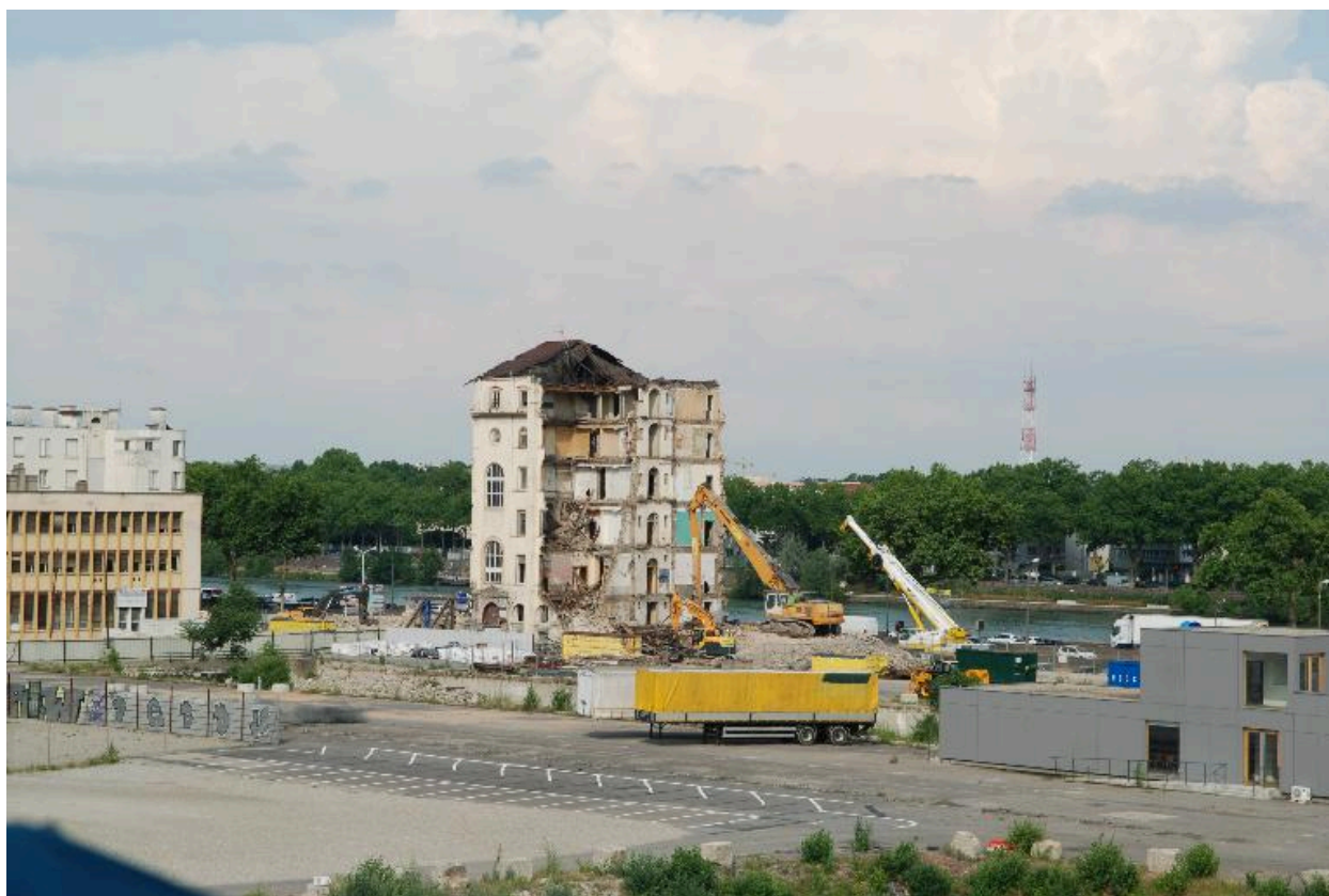
L'immeuble en cours de démolition
