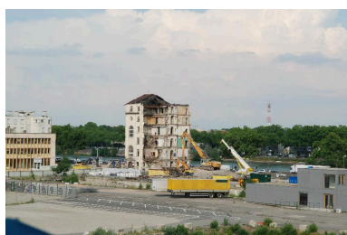
L'immeuble en cours de démolition Phot. Thierry Monnet IVR82_20156902405NUCA
