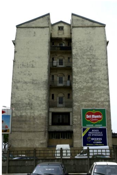
Vue du pignon nord et des coursières intérieures Phot. François Blanchetière IVR82_20016902136NUCA
