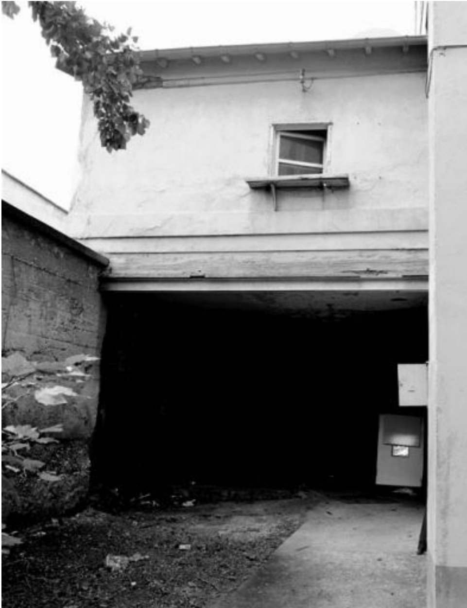
Vue de la logge de concierge en surplomb sur l'élévation postérieure
