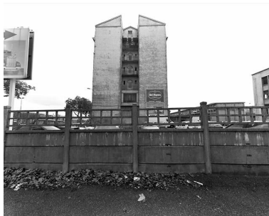
Élévation latérale nord Phot. Jean-Marie Refflé IVR82_20026900091P
