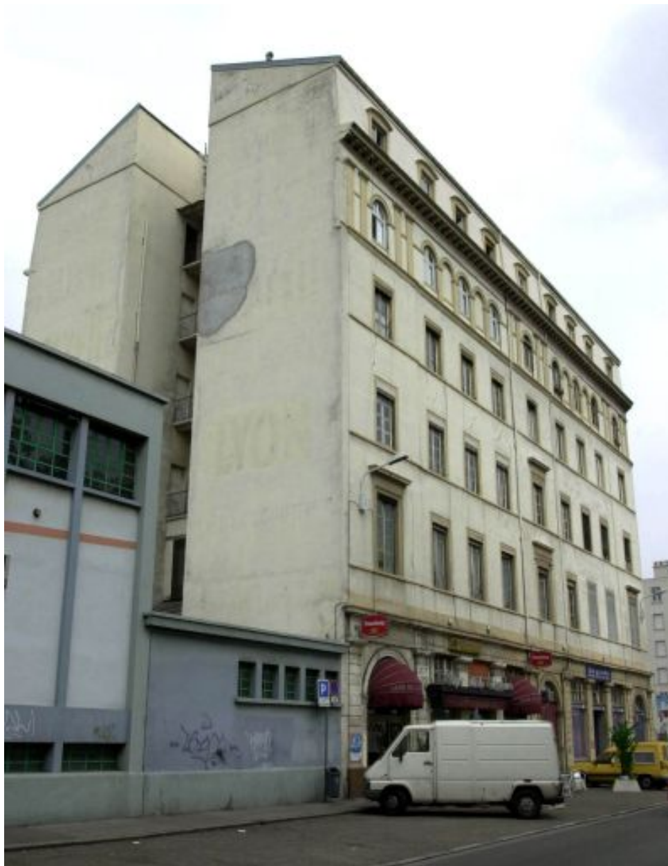
Vue de 3/4 gauche : l'élévation principale et le pignon sud
