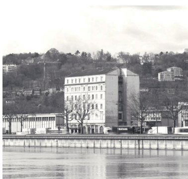
Vue d'ensemble depuis l'est Phot. Eric Dessert IVR82_20026903024X
