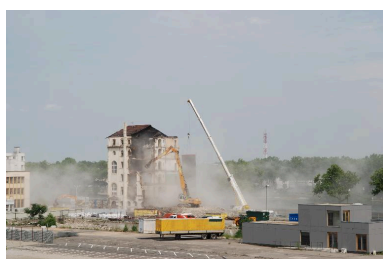
L'immeuble en cours de démolition Phot. Thierry Monnet IVR82_20156902402NUCA
