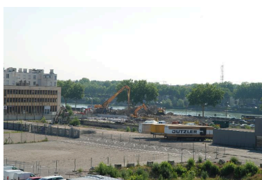
Après la démolition Phot. Thierry Monnet IVR82_20156902406NUCA
