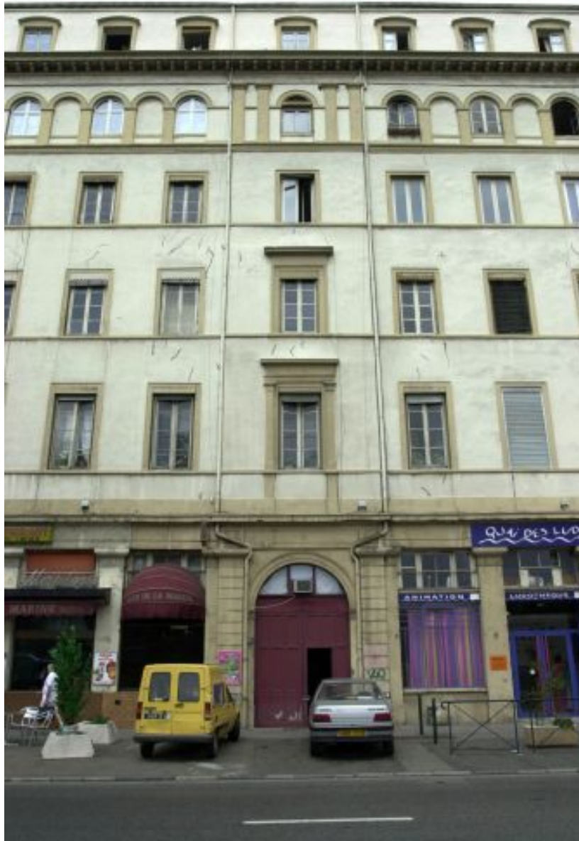
Travée centrale de l'élévation principale
