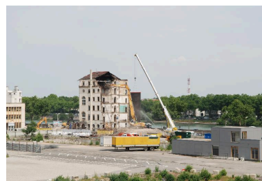
L'immeuble en cours de démolition Phot. Thierry Monnet IVR82_20156902401NUCA
