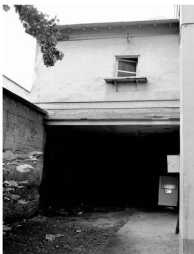
Vue de la loge de concierge en surplomb sur l'élévation postérieure Phot. Jean-Marie Refflé IVR82_20026900093X
