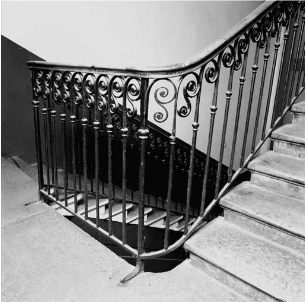
Détail de la rampe d'escalier
