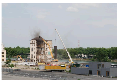
L'immeuble en cours de démolition Phot. Thierry Monnet IVR82_20156902403NUCA
