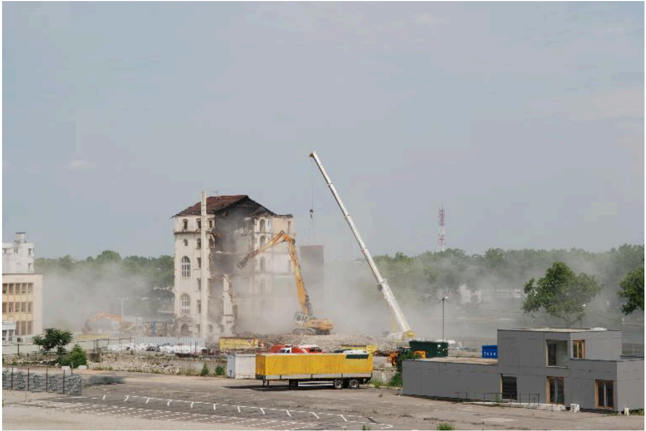
L'immeuble en cours de démolition
