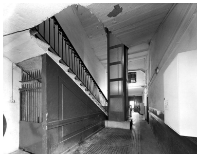
Vue du vestibule et de l'escalier depuis le fond de l'immeuble Phot. Jean-Marie Refflé IVR82_20026900094V
