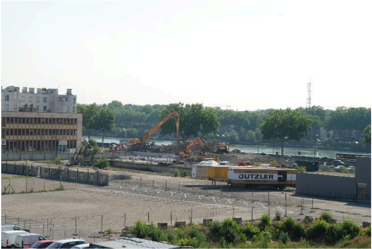
Après la démolition
