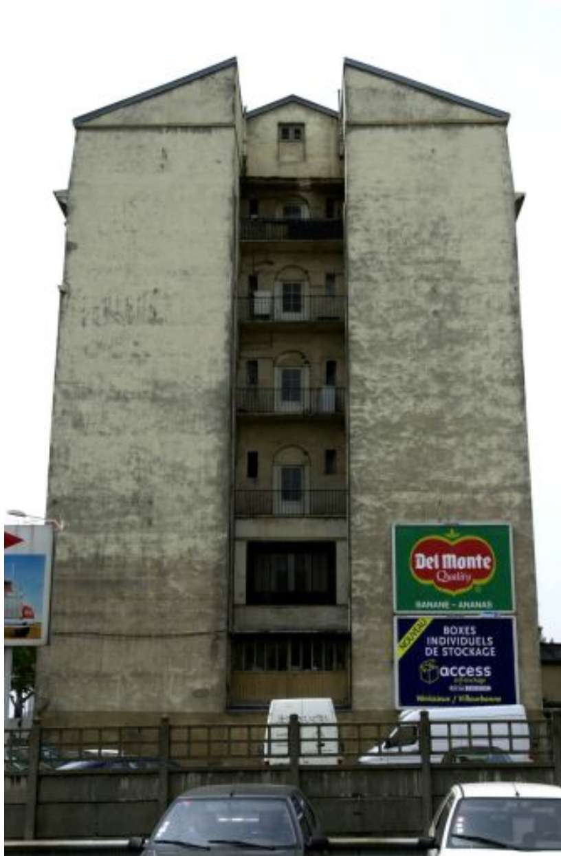
Vue du pignon nord et des coursières intérieures
