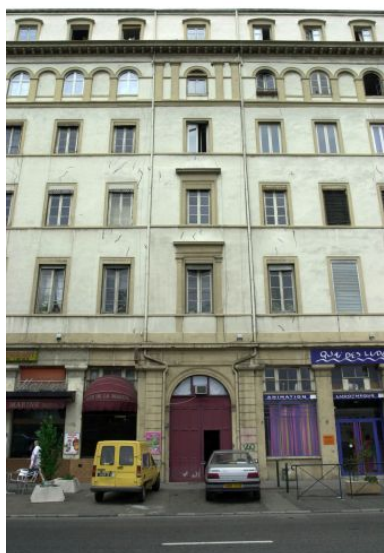
Travée centrale de l'élévation principale Phot. François Blanchetière IVR82_20016902137NUCA
