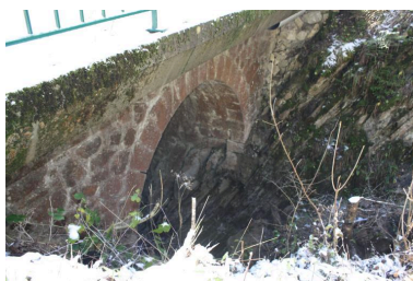
Pont des Granges, détails voûte, culée et plinthe Phot. Benoît Huraut IVR84_20207401273NUCA
