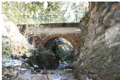
Pont des Granges, face amont IVR84_20197401283NUCA
