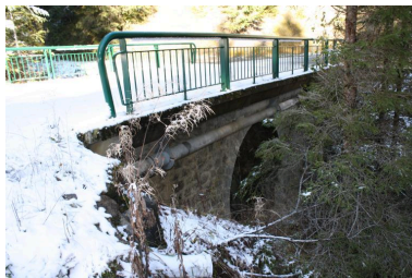
Pont des Granges, face aval Phot. Benoît Huraut IVR84_20207401270NUCA
