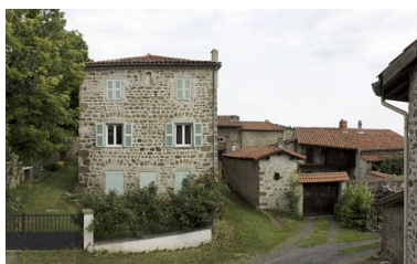
Vue de la façade sud. Phot. Didier Gourbin IVR82_20074200128NUCAQ
