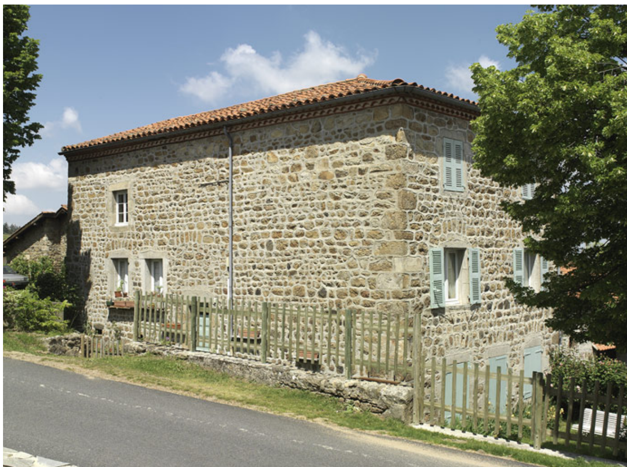
Vue de trois-quarts sud-ouest.
