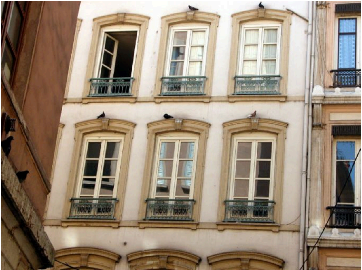
Façade sur rue, détail des 3e et 4e niveaux
