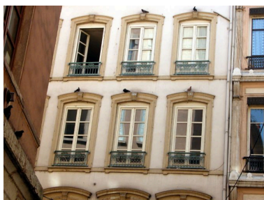
Façade sur rue, détail des 3e et 4e niveaux Phot. Bernard Ducouret IVR82_20046900685NUCA
