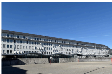
Bâtiment d'enseignement général nord-ouest Phot. Catherine Guégan IVR84_20241500037NUCA
