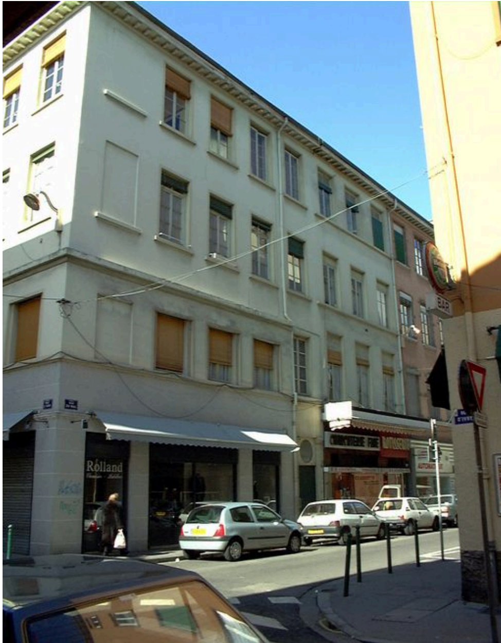
Vue générale depuis le sud
