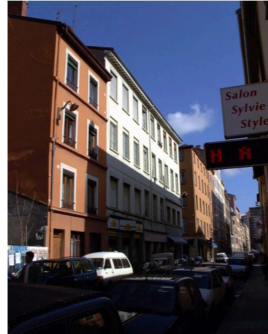
Elévation, rue d'Ivry Phot. Véronique Belle IVR82_20006900395NUCA
