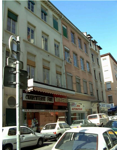
Elévation rue du Mail, partie nord Phot. Véronique Belle IVR82_20006900397NUCA
