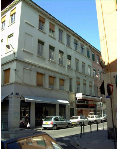
Vue générale depuis le sud Phot. Véronique Belle IVR82_20006900396NUCA
