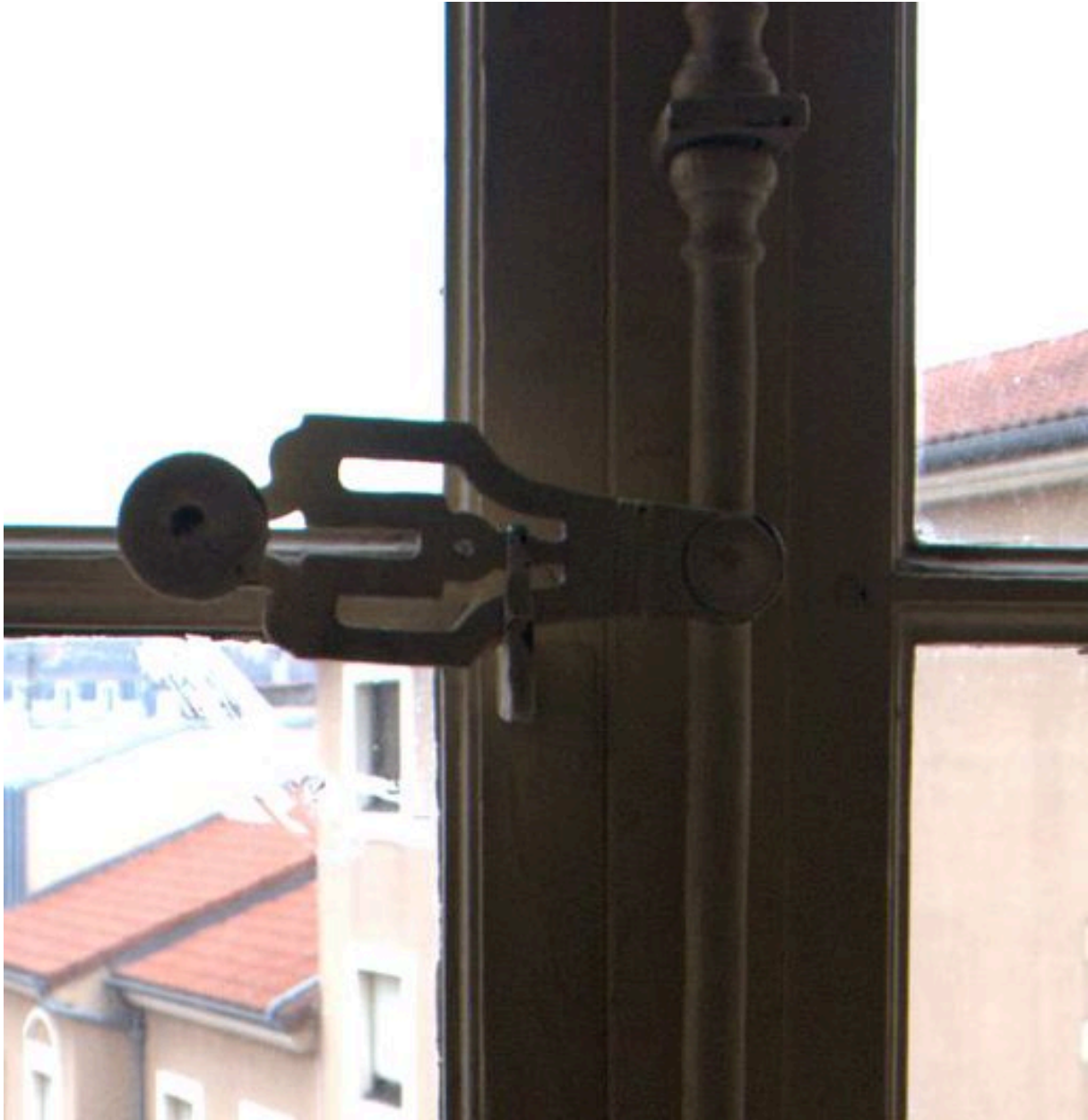
Crémone d'une fenêtre de l'escalier
