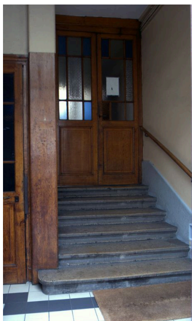
L'escalier et la porte vitrée du vestibule Phot. Maryannick Chalabi IVR82_20086900778NUCA
