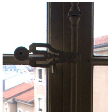
Crémone d'une fenêtre de l'escalier Phot. Maryannick Chalabi IVR82_20086900791NUCA
