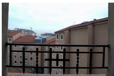
Garde-corps d'une fenêtre de l'escalier Phot. Maryannick Chalabi IVR82_20086900792NUCA
