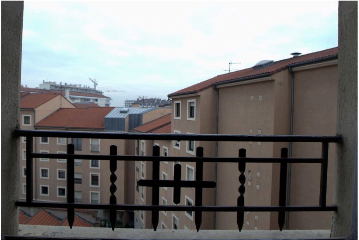
Garde-corps d'une fenêtre de l'escalier
