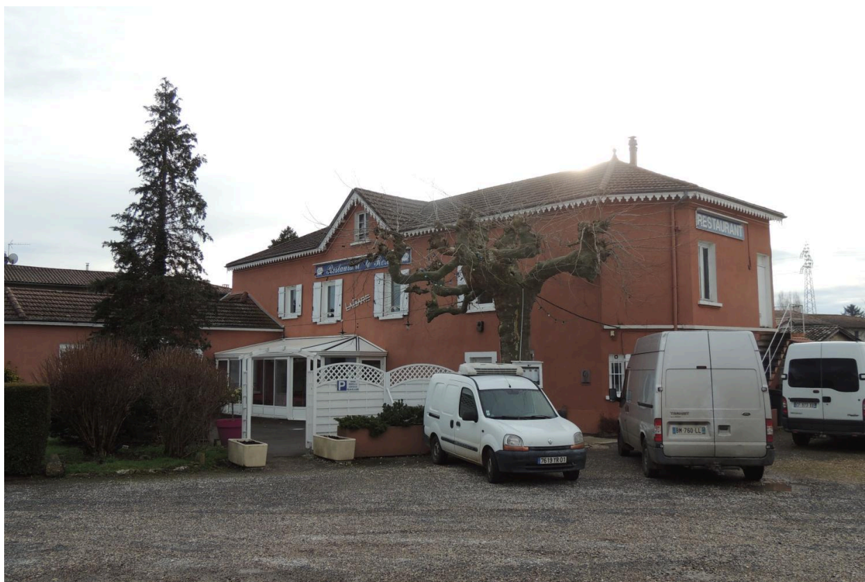
La gare, vue d'ensemble.
