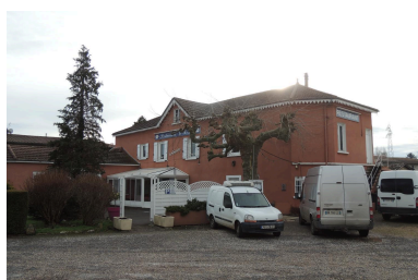
La gare, vue d'ensemble. Phot. Elisabeth Dandel IVR84_20210100086NUCA
