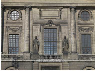
Vue générale Phot. Eric Dessert IVR82_20106902174NUCA
