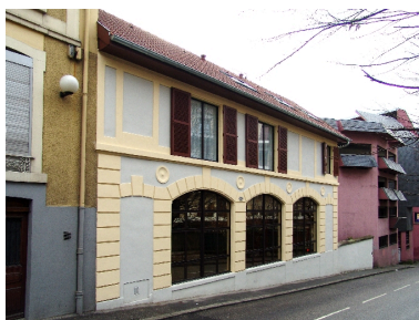
Façade après restauration Phot. François Fouger IVR82_20097300065NUCA
