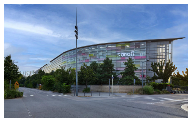
Vue d'ensemble sud, Usine Sanofi Genzyme, Lyon 7e Phot. Franck Trabouillet IVR84_20246900876NUCA
