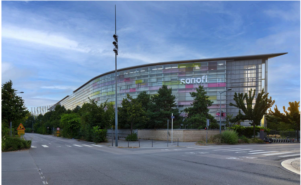
Vue d'ensemble sud, Usine Sanofi Genzime, Lyon 7e
