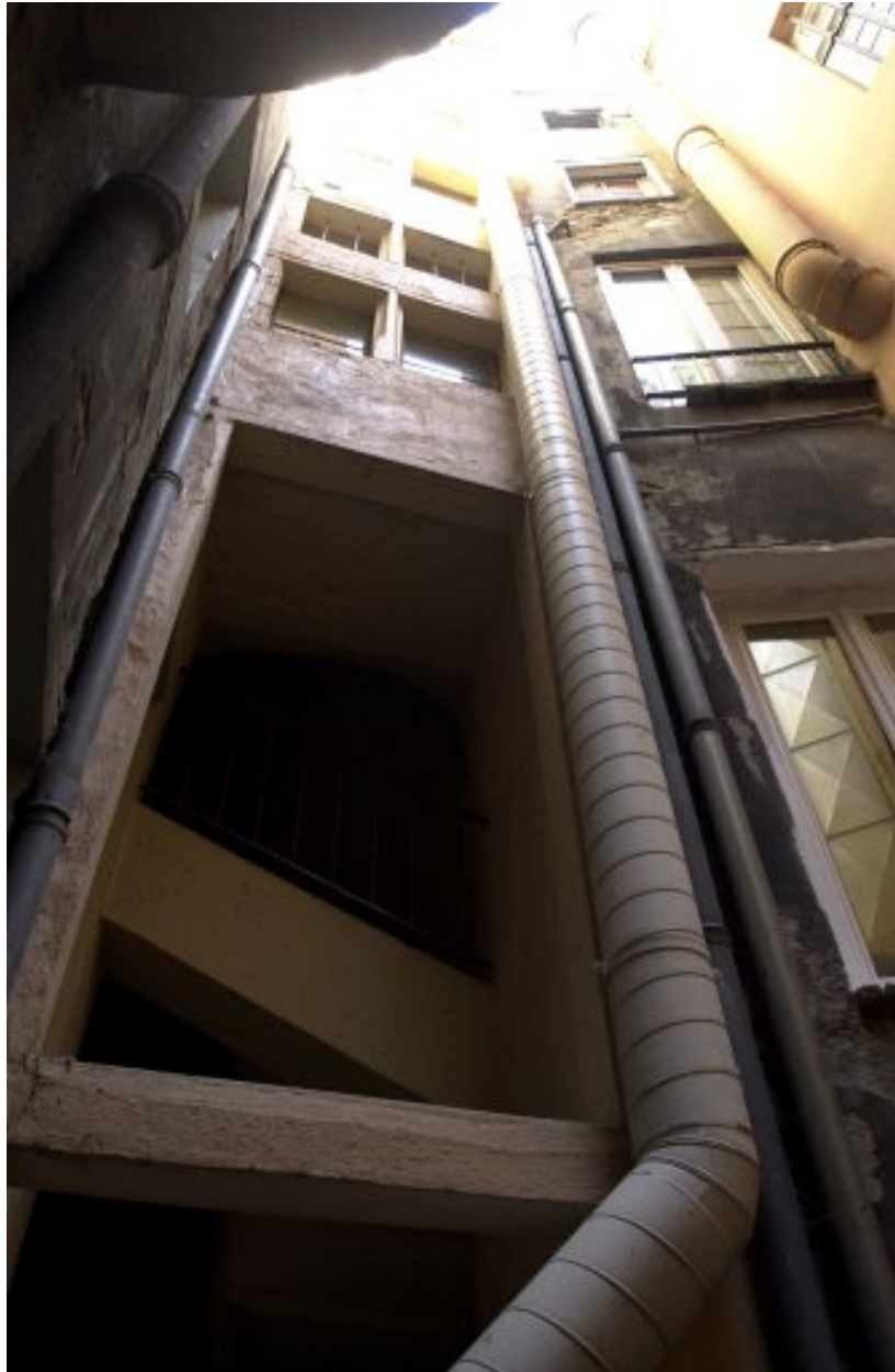
Façade sur cour de l'escalier, partie supérieure
