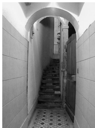
Escalier vu depuis l'allée Phot. Bernard Ducouret IVR82_20036901250NUC
