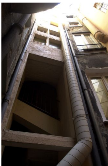
Façade sur cour de l'escalier, partie supérieure Phot. Bernard Ducouret IVR82_20036901253NUCA
