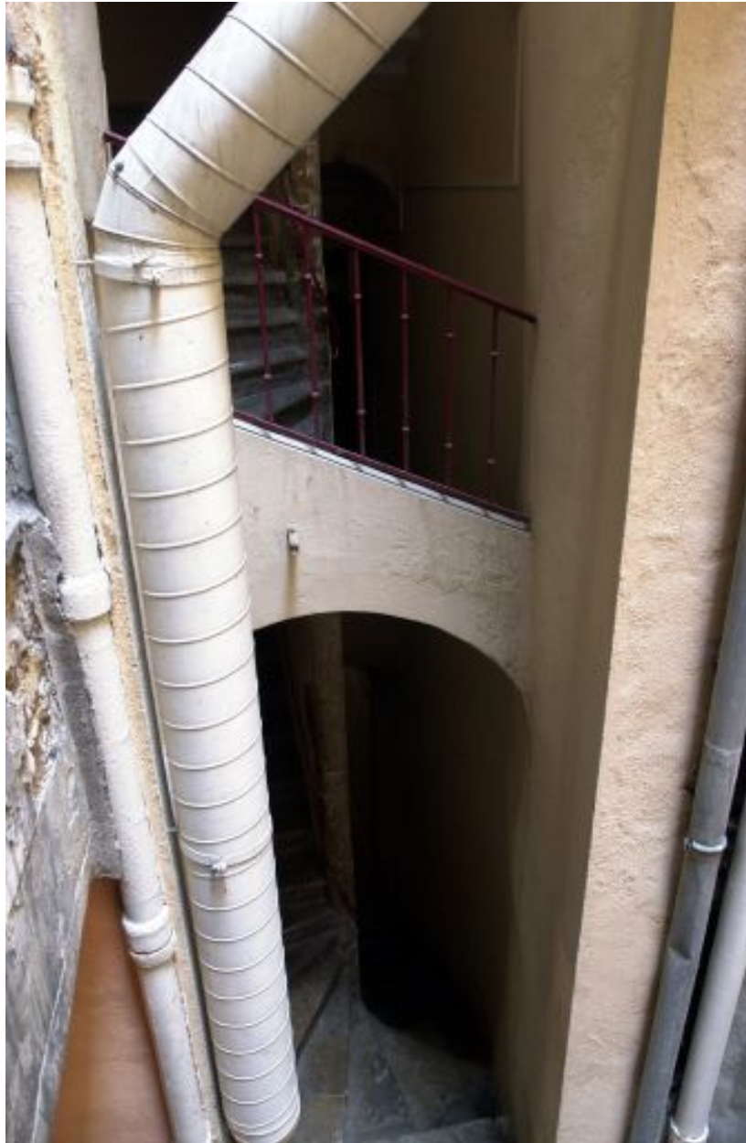
Façade sur cour de l'escalier, partie inférieure
