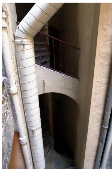
Façade sur cour de l'escalier, partie inférieure Phot. Bernard Ducouret IVR82_20036901252NUCA
