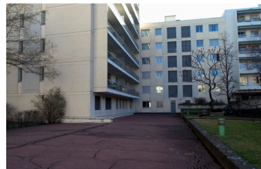
Elévation postérieure Phot. Maryannick Chalabi IVR82_20116904141NUCA
