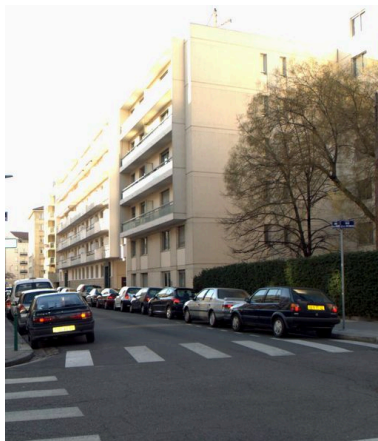
Vue générale depuis le nord Phot. Maryannick Chalabi IVR82_20116904142NUCA
