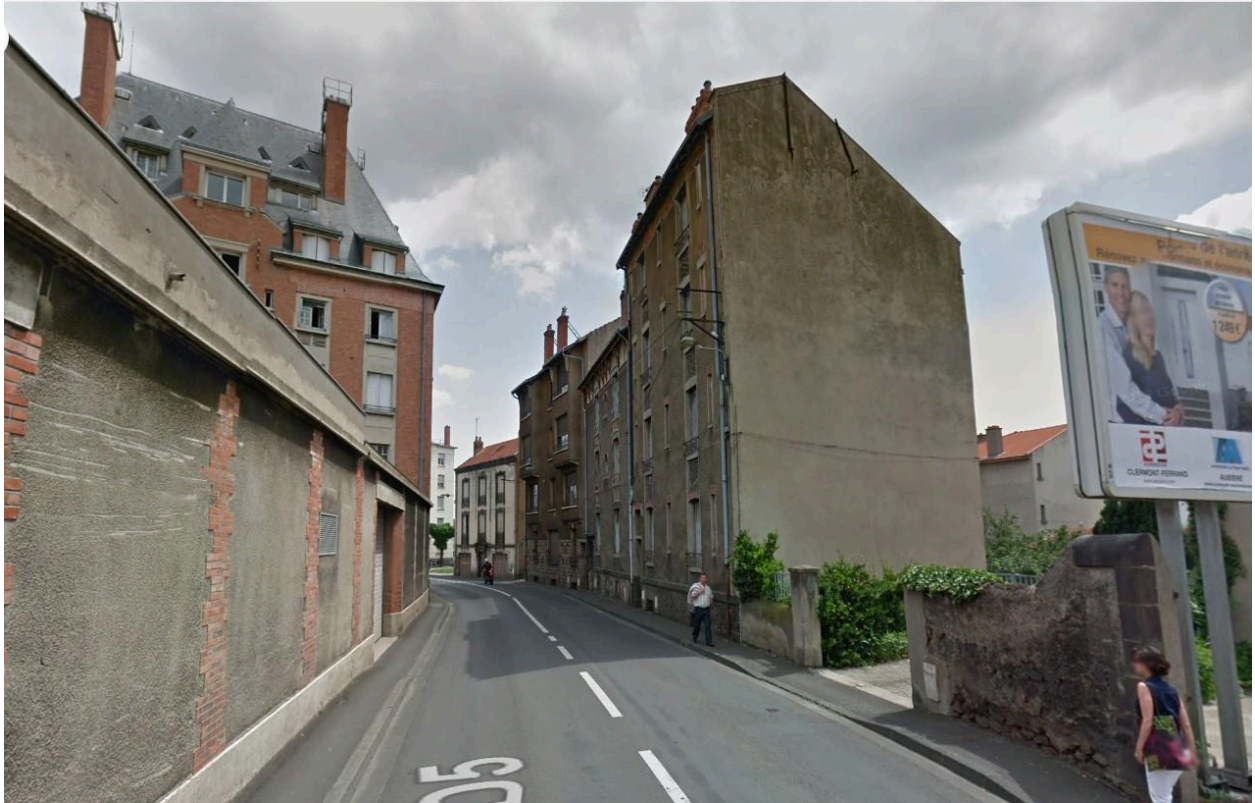
Immeubles détruits sur l'avenue Pasteur (à droite). Avant la construction d'une résidence.
