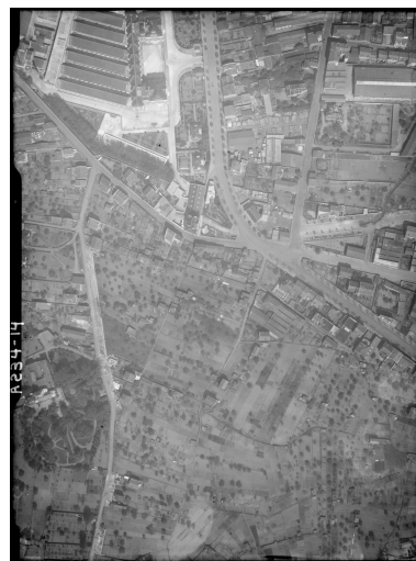
Parcellaire avant ouverture du boulevard Aristide-Briand. Au nord-ouest l'imprimerie de la banque de France, à l'est carrefour des boulevards Duclaux, Pasteur et de la rue Eugène-Gilbert. Repro. Félicie Fougère , Autr. auteur inconnu IVR84_20256302266NUCA
