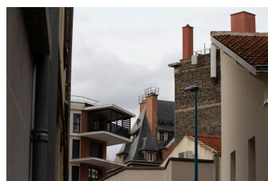
Vue des toitures de l'angle des boulevard Aristide Briand et Duclaux, depuis la rue Fabert Phot. François-Nicolas L'Hardy IVR84_20256300371NUCA
