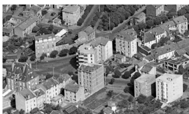
Ilot triangulaire entre l'avenue Pasteur, la rue Gourguillon et le boulevard Aristide-Briand Repro. Félicie Fougère , Autr. auteur inconnu IVR84_20256302419NUC
