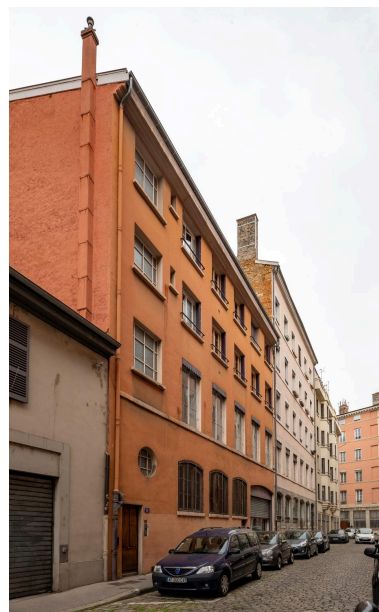
Elévation rue Guynemer Phot. Michel Pérès IVR84_20216900384NUCA
