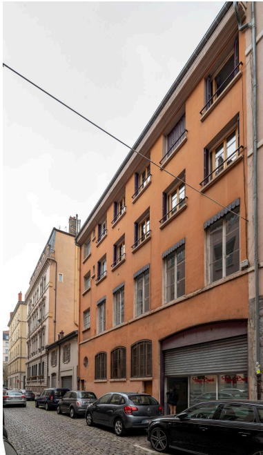
Elévation rue Guynemer Phot. Michel Pérès IVR84_20216900385NUCA
