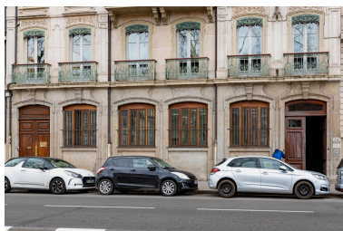
Le rez-de-chaussée et l'entresol quai Tilsitt Phot. Michel Pérès IVR84_20216900390NUCA
