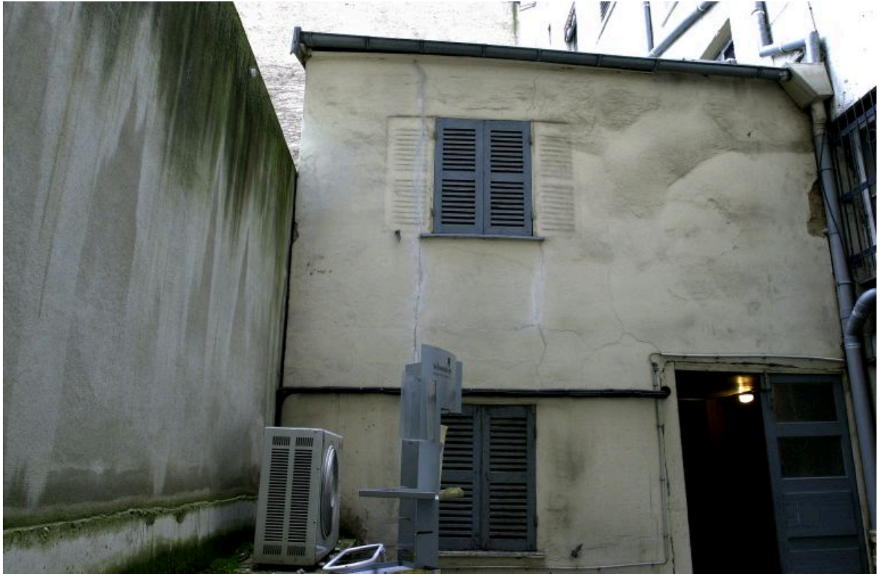
Vue de la loge de concierge depuis la cour
