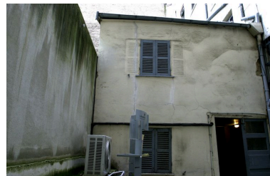
Vue de la loge de concierge depuis la cour Phot. Maryannick Chalabi IVR82_20016900261NUCA
