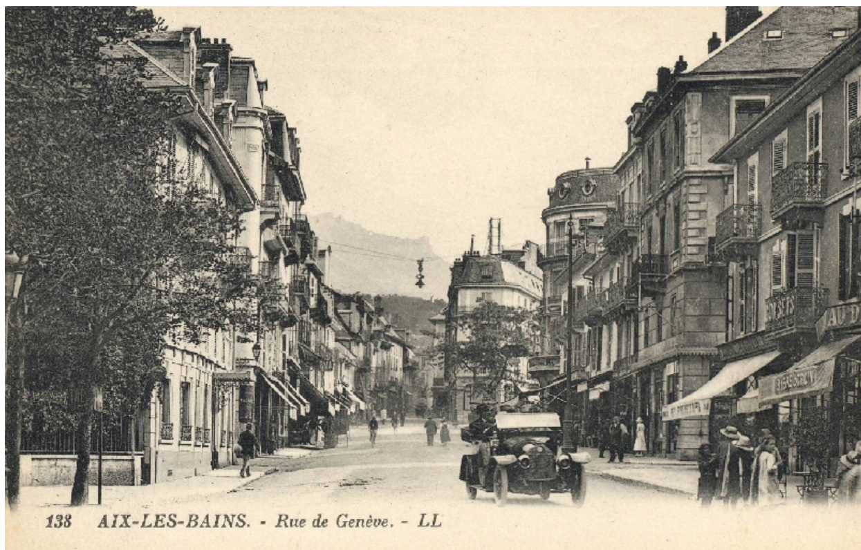
Façade sur la rue de Genève
