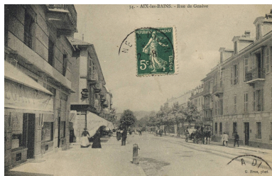
Détail de la façade sur la rue de Genève Repro. François Fouger IVR82_20057300976NUCB
