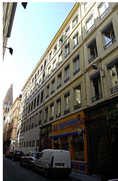
Façade sur la rue Pléney Phot. Bernard Ducouret IVR82_20046900162NUCA
