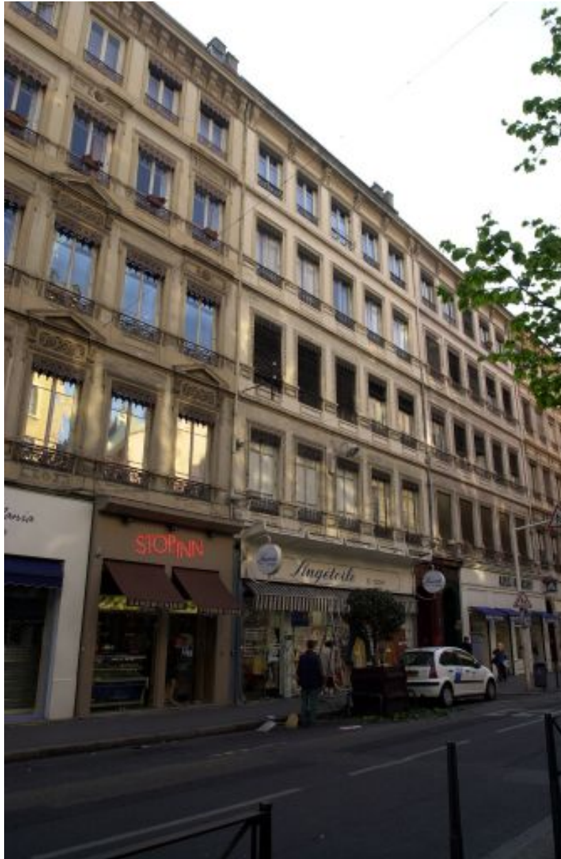
Façade principale, vue générale
